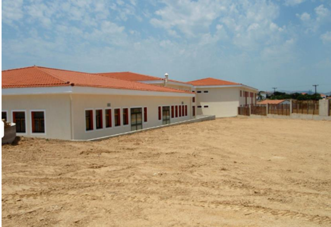
Εικόνα 10: Βορειοανατολική άποψη του συγκροτήματος (κτίριο V)
