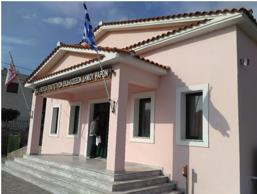
Εικόνα 52: Νότιοανατολική άποψη του κτιρίου.
