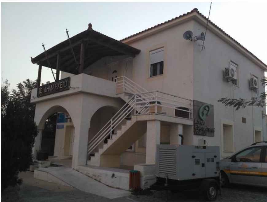
Εικόνα 31: Βορειοανατολική άποψη του κτιρίου
