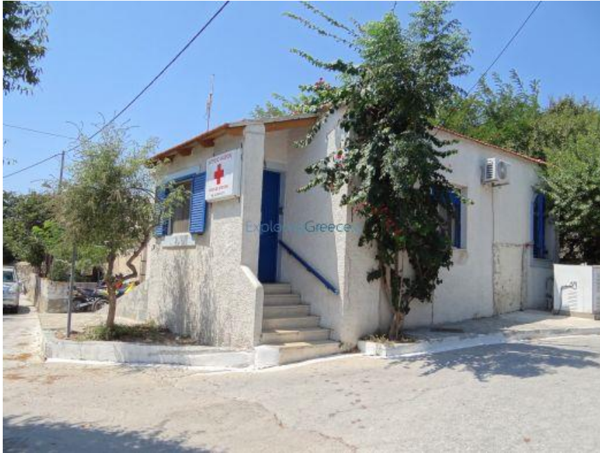
Εικόνα 42: Νότιοανατολική άποψη του κτιρίου
