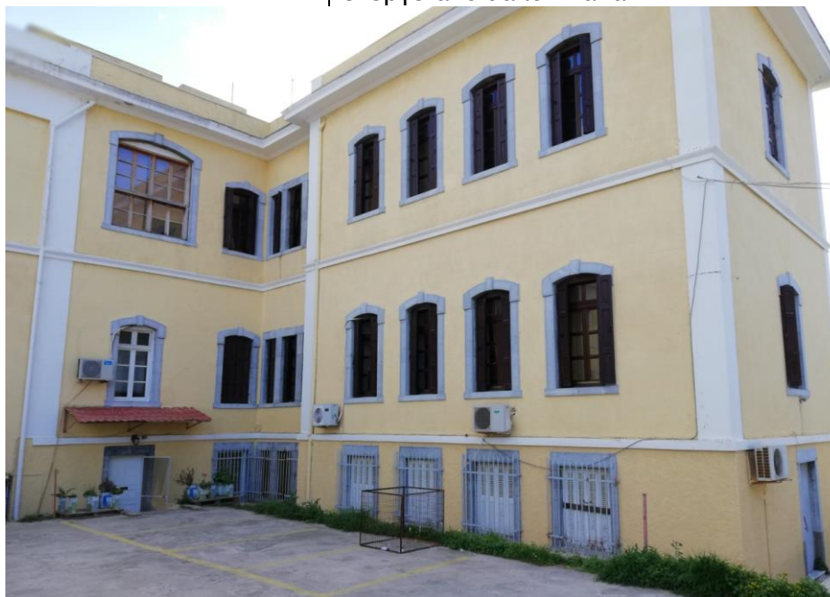
Εικόνα 30: Κτίριο Γ.Ν. Καλύμνου «Το Βουβάλειο» (παλαιό τμήμα)
