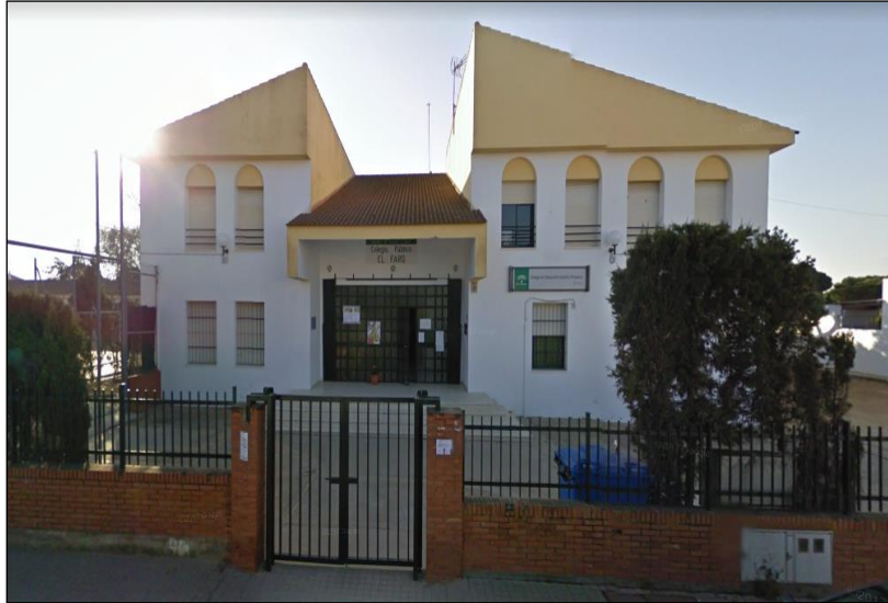
Ilustración 2. Fachada del CEIP El Faro
