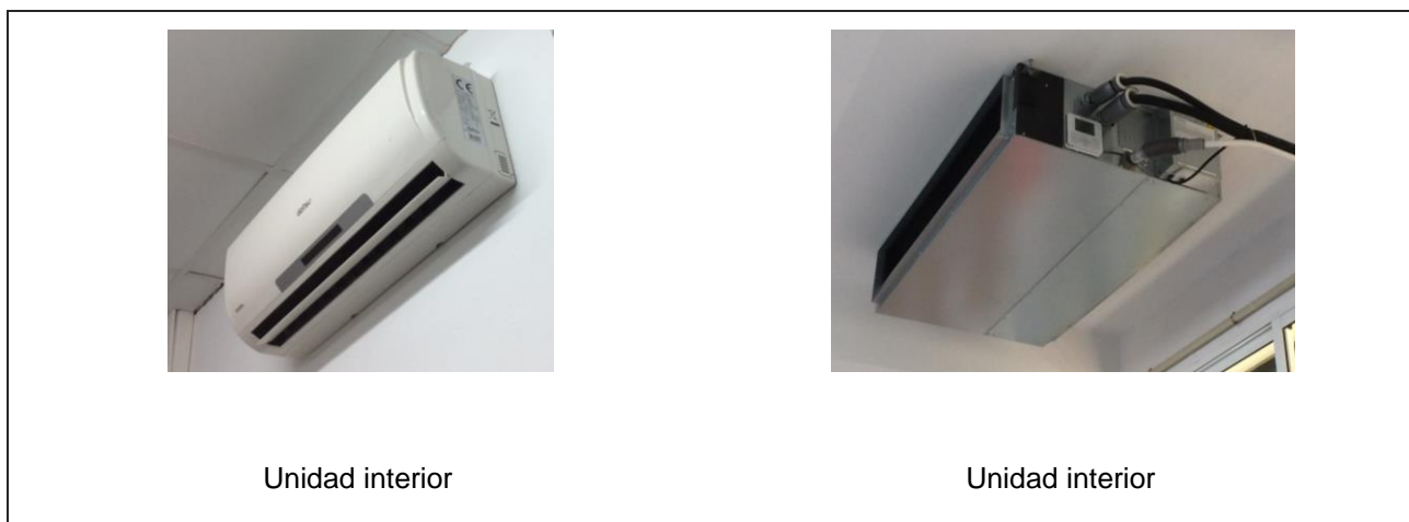
Ilustración 4. Equipos autónomos de refrigeración
