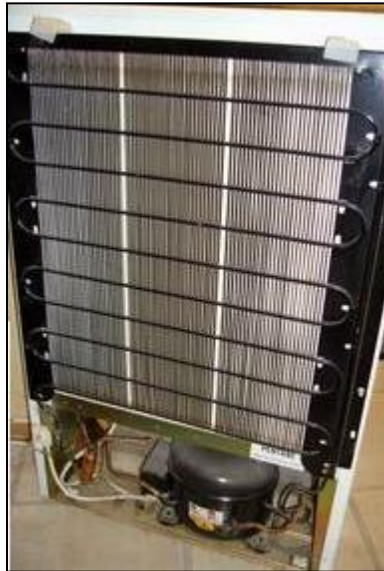
Ilustración 20. Parte trasera de un frigorífico.
