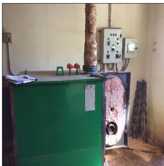
Ilustración 3. Caldera para calefacción del edificio
