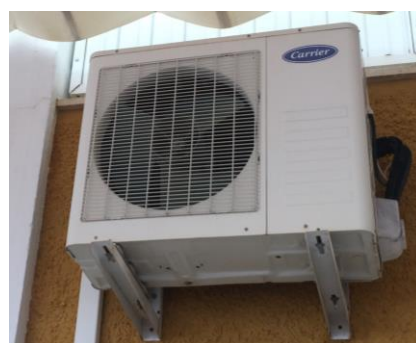
Equipo autónomo de calefacción
