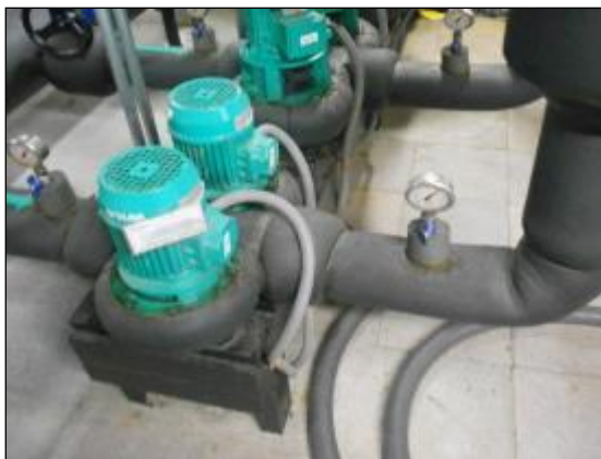
Ilustración 20. Ejemplo de aislamiento térmico en bombeo
