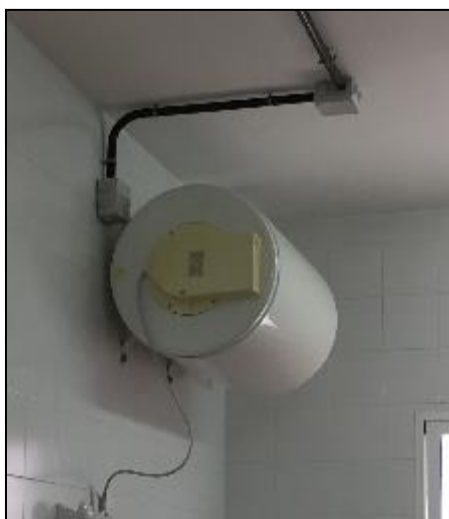
Ilustración 5. Termo eléctrico
