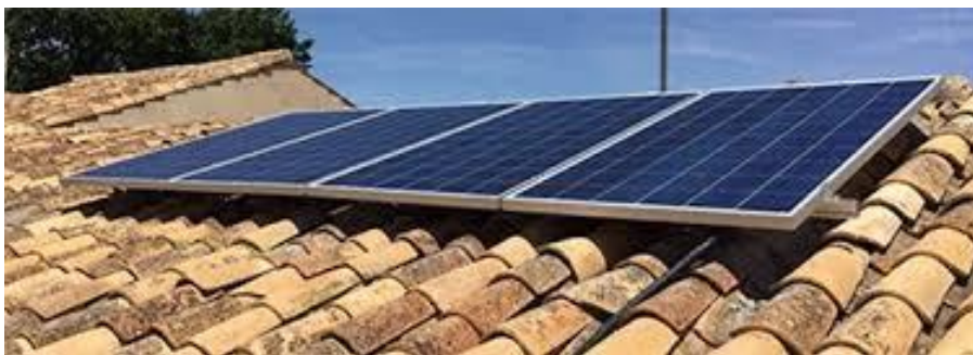
Ilustración 17. Ejemplo de estructura para placas fotovoltaicas en cubiertas inclinadas
