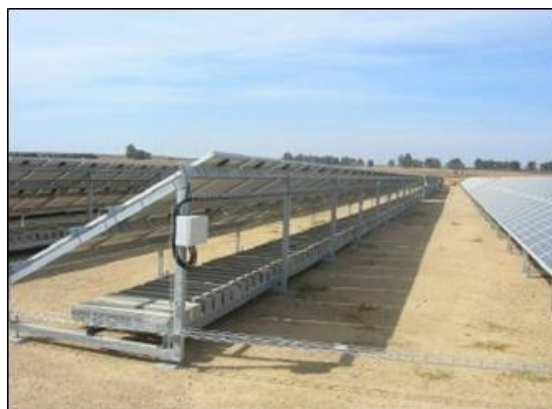
Ilustración 13. Imagen de una instalación fotovoltaica estática
