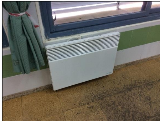
Ilustración 3. Radiador eléctrico
