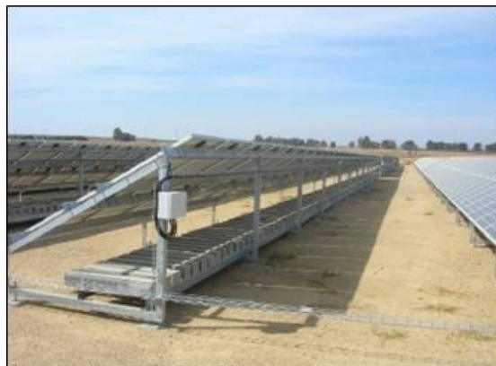
Ilustración 12. Imagen de una instalación fotovoltaica estática
