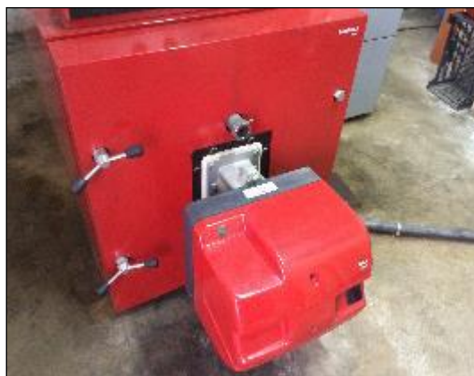
Ilustración 3. Caldera para dar suministro al sistema de calefacción
