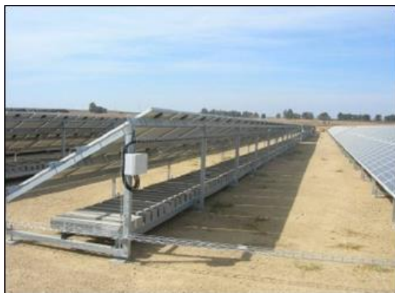
Ilustración 13. Imagen de una instalación fotovoltaica estática
