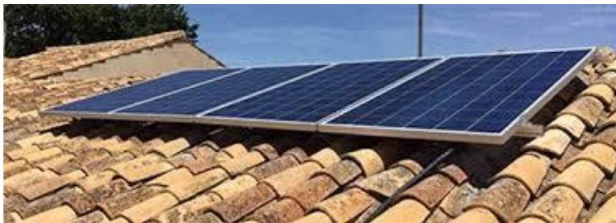
Ilustración 19. Ejemplo de estructura para placas fotovoltaicas en cubiertas inclinadas
