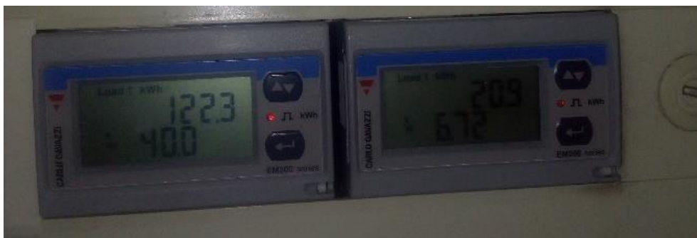
Figura 5 - Sistema de controlo e monitorização de consumos energéticos.
