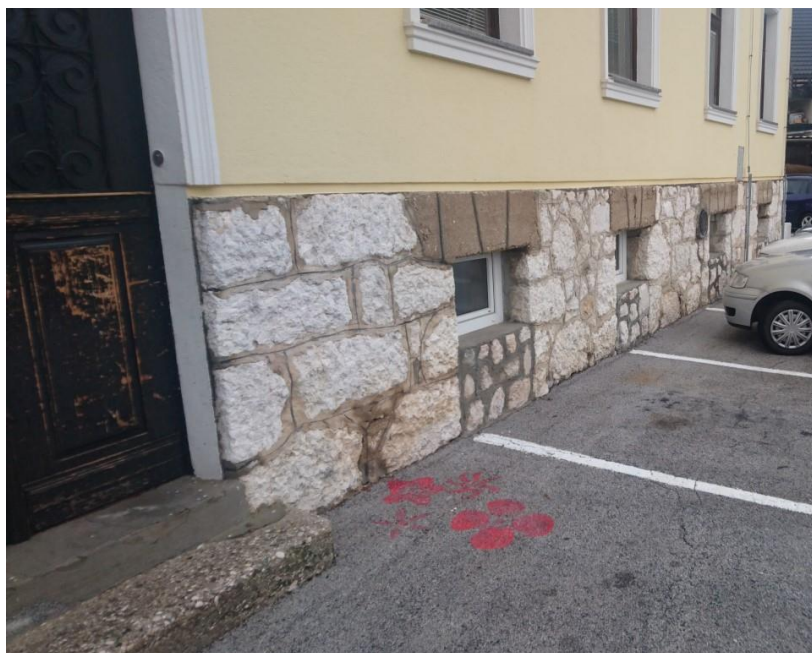
Slika 33: Podzidek in fasada ter dvoslojna termopan okna s PVC okvirji.
