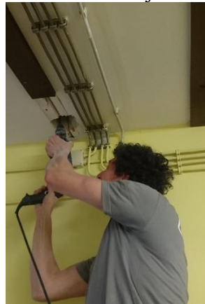
Izvedba testa pritr. izolacije
