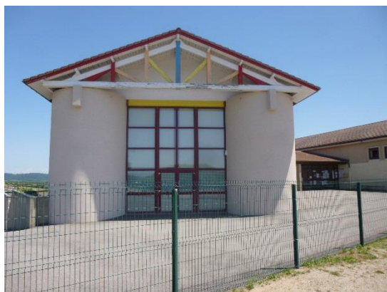
Façade est-Salle polyvalente
