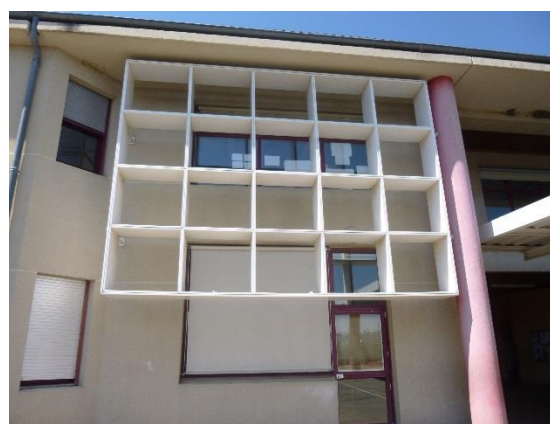
Brise soleil façade Sud
