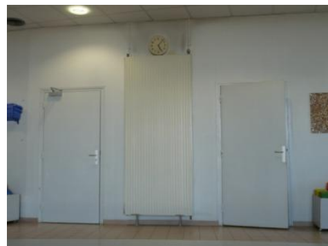
Radiateur à lame d'eau
