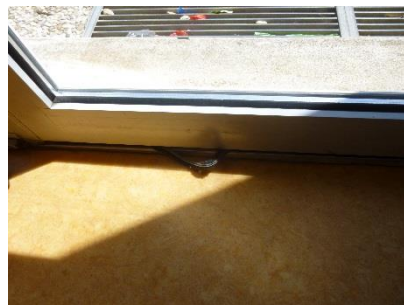
Joints usés dans le GS
