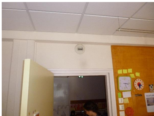
Bouche d'extraction d'air dans les pièces (sauf la salle Tahiti)
