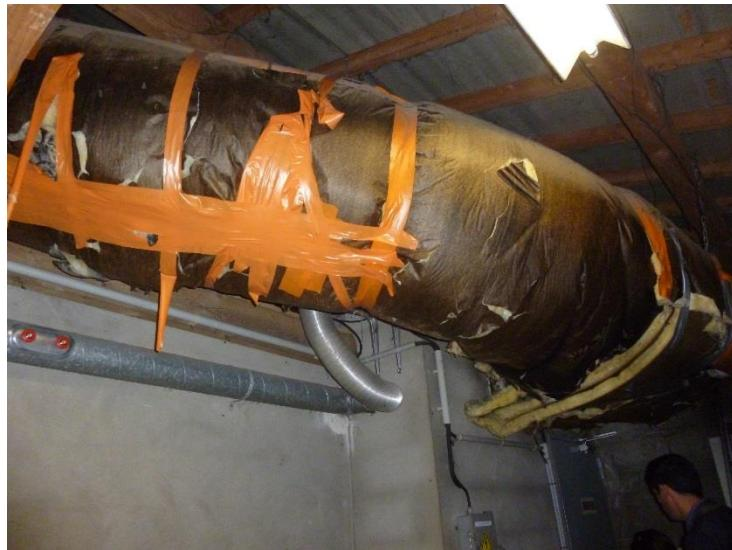
*Calorifugeage autour des gaines de distribution*
