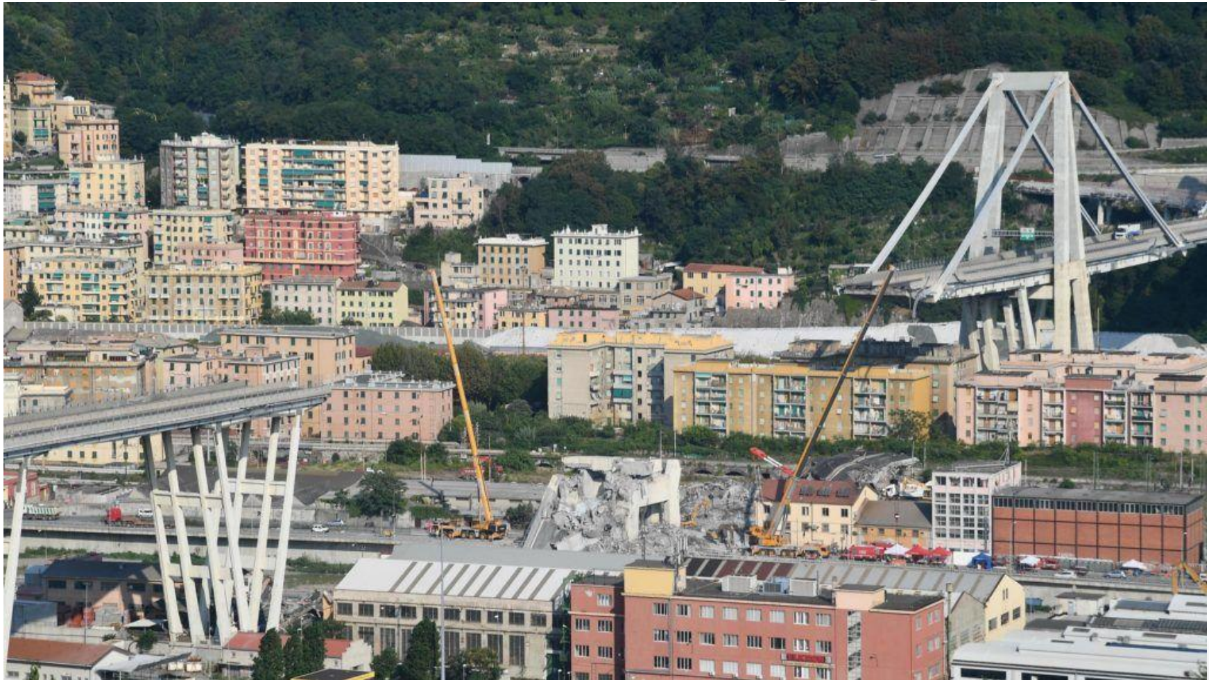
Genova, Morandi bridge, 14.08.2018.
