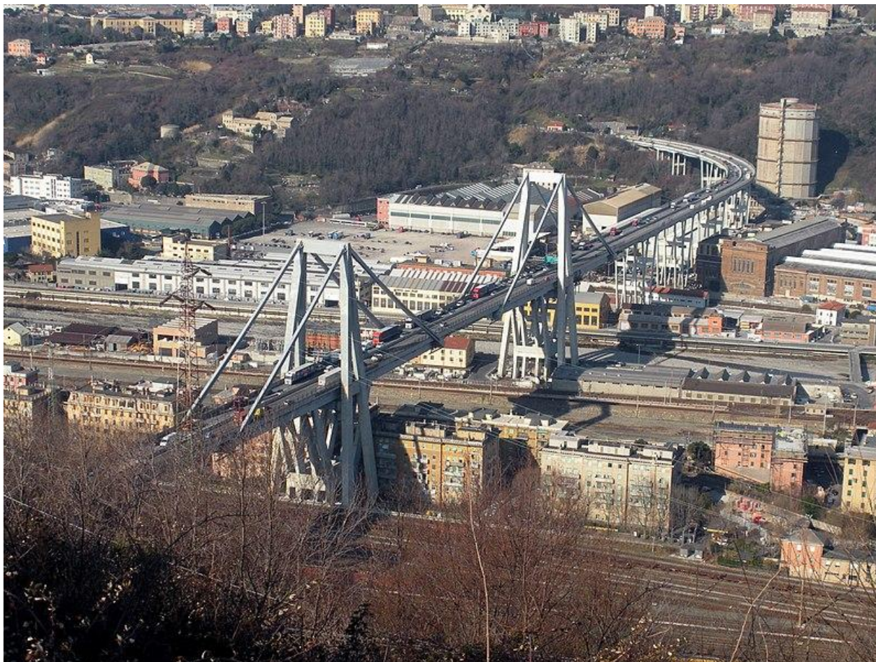
Genova, Morandi bridge, 14.08.2018.
