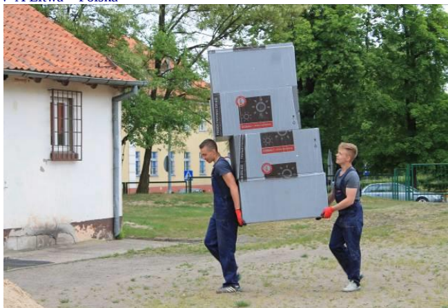
Foto 40. „Osobowy” transport materiałów do termomodernizacji z magazynu na plac budowy
