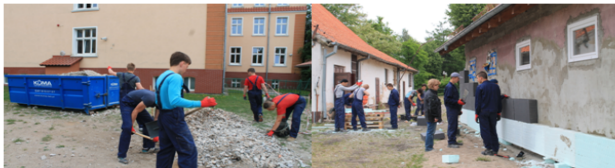
Foto 8. Stary tynk po skuciu. Przyklejanie pierwszych płyt styropianu...
