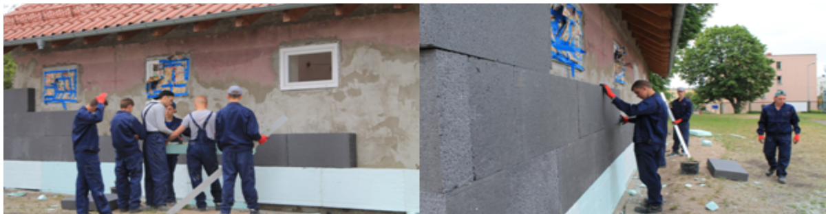
Foto 9. Przyklejanie kolejnych płyt
