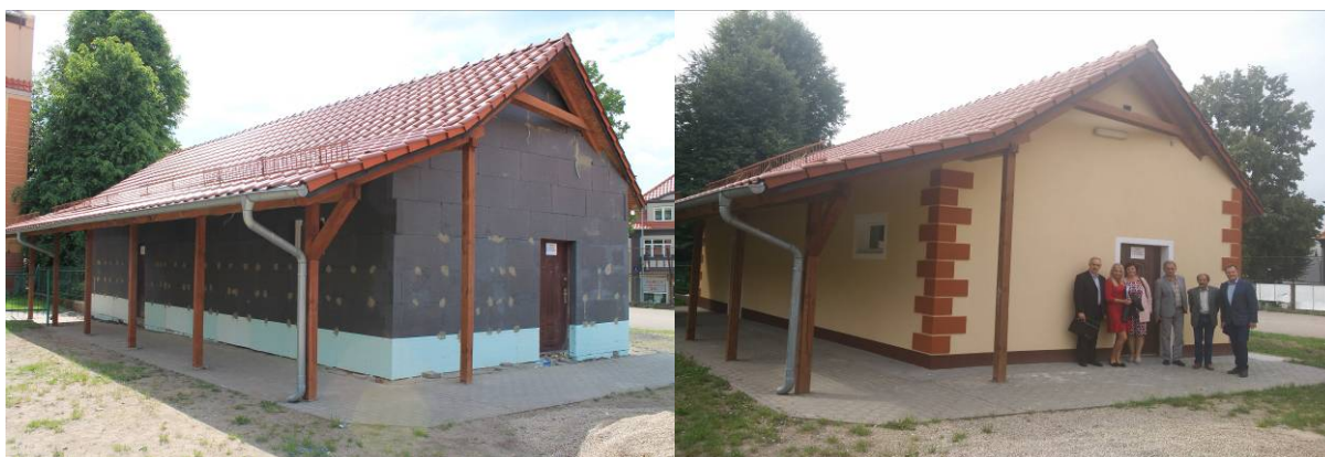
Foto 10. Cały budynek oklejony i zakołkowany. Wykonana kompletna termomodernizacja –może się sfotografować Zespół Projektowy.
