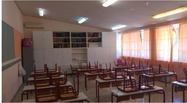
Φωτισμός & κλιματιστικό σε αίθουσα διδασκαλίας
