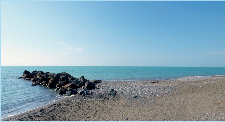
Figure 2.7. Gravier accumulé du côté au-dessus du flux d'un épi sur la plage au sud de Marina di Cecina (Livourne).
