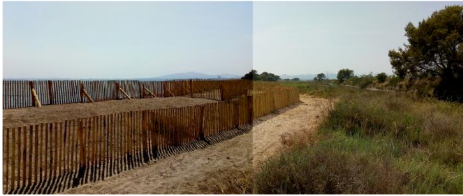
Figura 20: Evoluzione del paesaggio dunale al punto 4 (dall'alto verso il basso: aprile 2019 prima dei lavori; maggio 2019: dopo la ricarica; giugno 2019: installazione delle gru; luglio 2019: a fine lavori)
