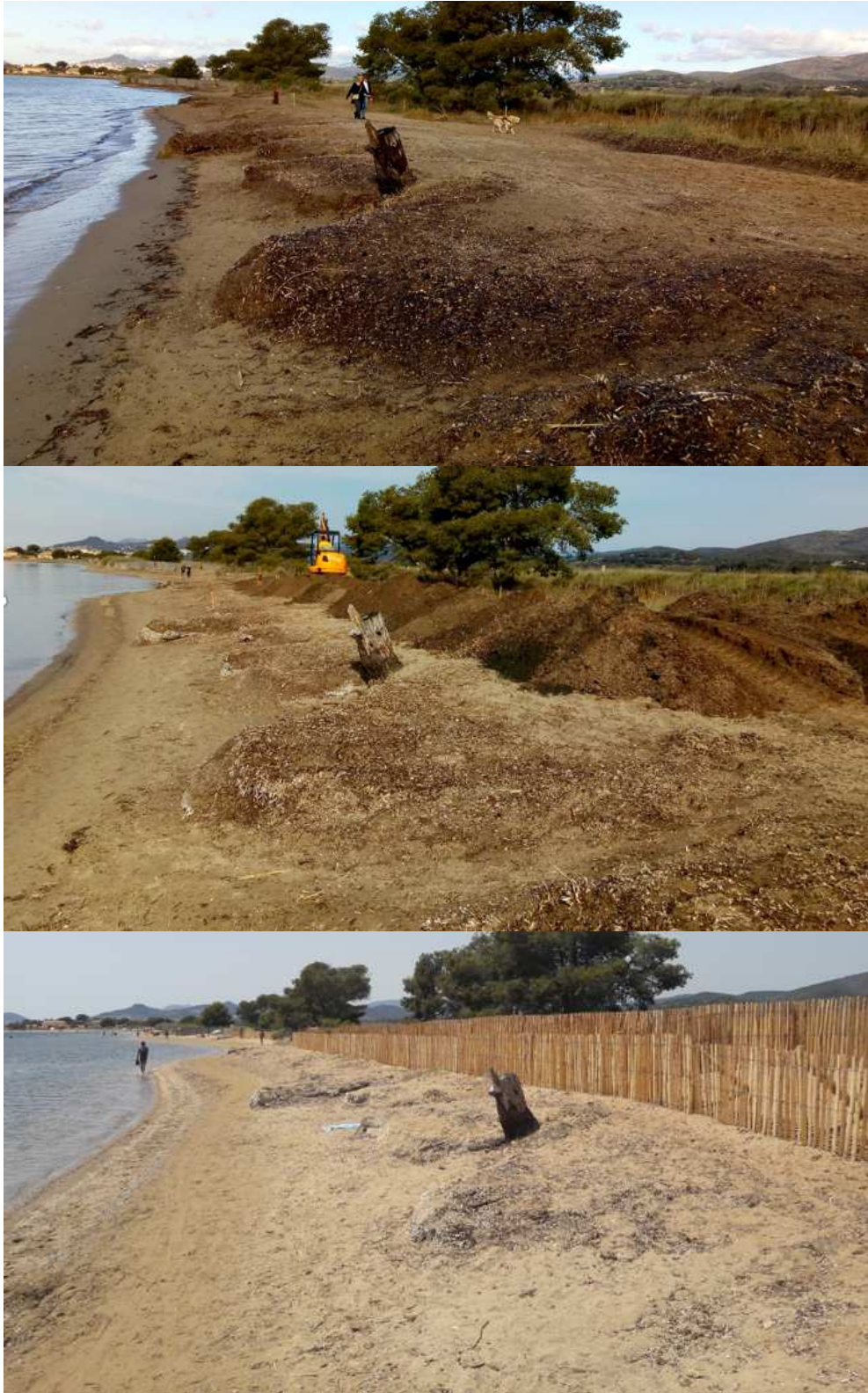
Figure 18 : Evolution du paysage dunaire au point 1 (de haut en bas : avril 2019 avant les travaux ; avril 2019 : pendant le rechargement ; juin 2019 : installation des ganivelles fin des travaux)
