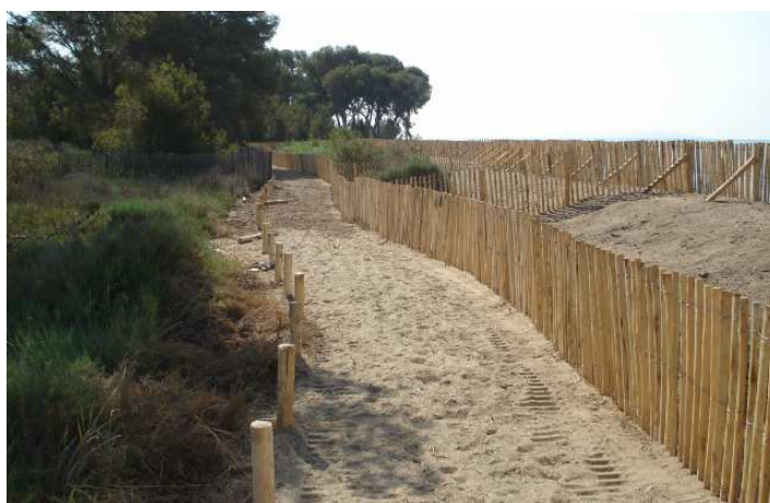
Figure 9 : Installation des guide-fils délimitant le sentier piéton en arrière du cordon dunaire
