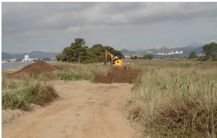
Figure 7 : Façonnage du profil de dune sur le littoral des Vieux Salins
