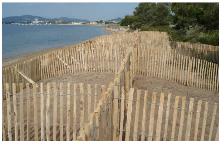
Figure 8 : Casiers de ganivelles installés sur le cordon dunaire
