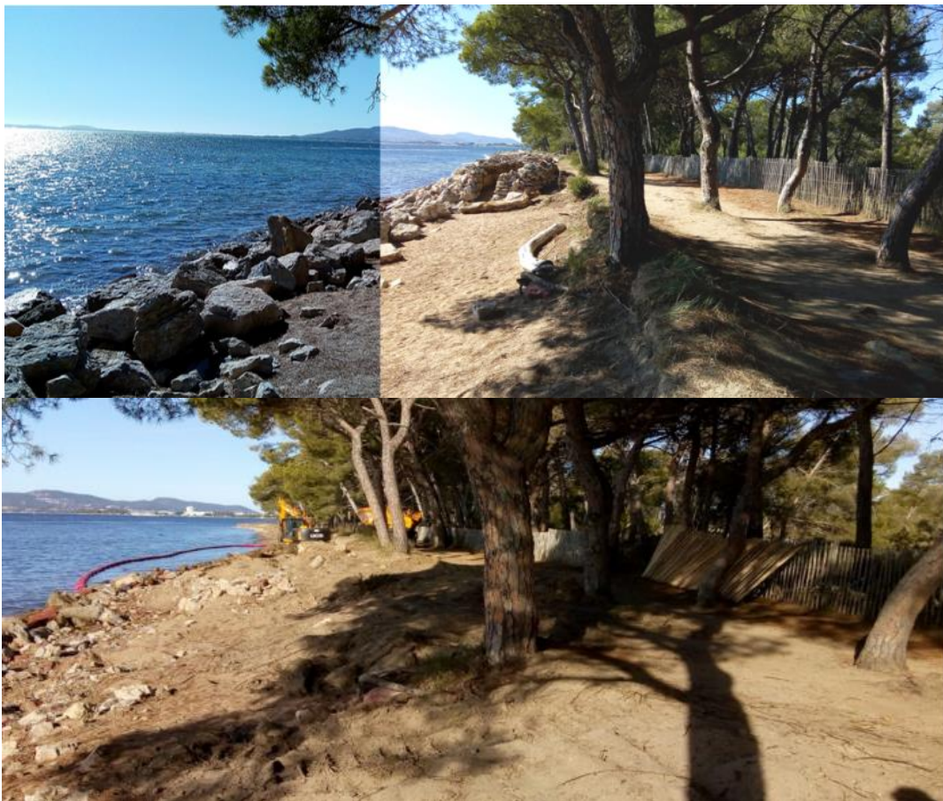
Figura 21: Evoluzione della sezione disaccoppiata al punto 5 (dall'alto verso il basso: settembre 2019 prima dei lavori; ottobre 2019: durante i lavori; 24 ottobre 2019: dopo i lavori e la tempesta)
