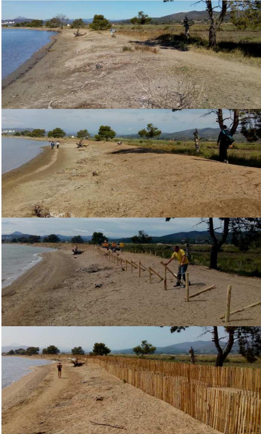
Figure 19 : Evolution du paysage dunaire au point 2 (de haut en bas : avril 2019 avant les travaux ; mai 2019 : après le rechargement ; juin 2019 : installation des ganivelles ; juillet 2019 : à la fin des travaux)
