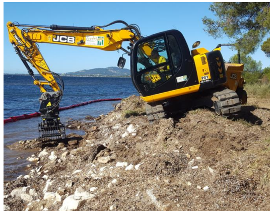
Figura 10: Rimozione dello strappo con una pinza idraulica "a scheletro"
