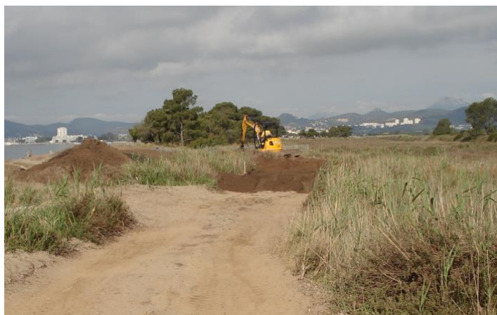
Figura 6: Modellamento del profilo della duna sul litorale del Vieux Salins
