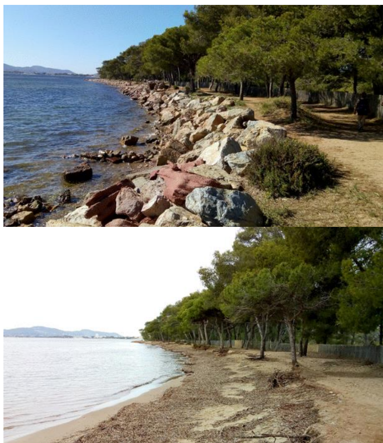
Figura 23: Evoluzione della sezione disaccoppiata al punto 7 (dall'alto verso il basso: settembre 2019 prima dei lavori; novembre 2019: dopo i lavori e la tempesta)
