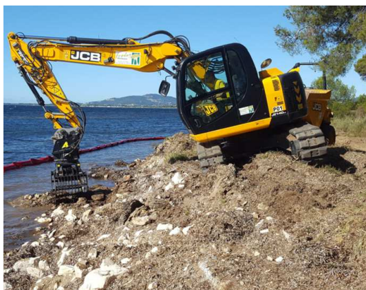
Figure 11 : Dépose des enrochements avec une pince hydraulique « squelette »
