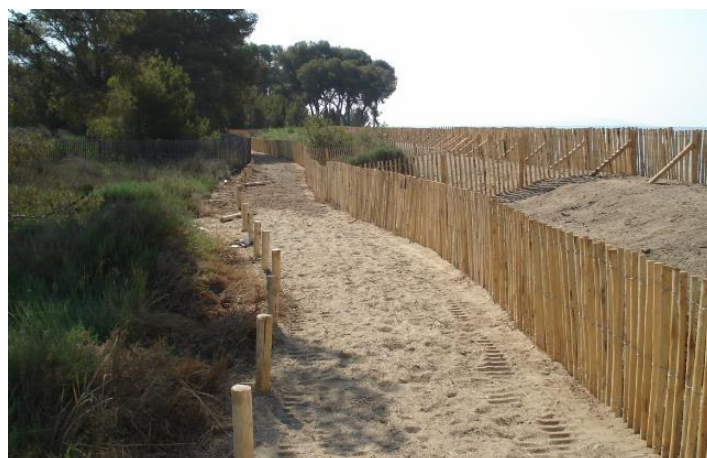
Figura 8: Installazione dei guidafili che delimitano il percorso pedonale dietro il crinale della duna
