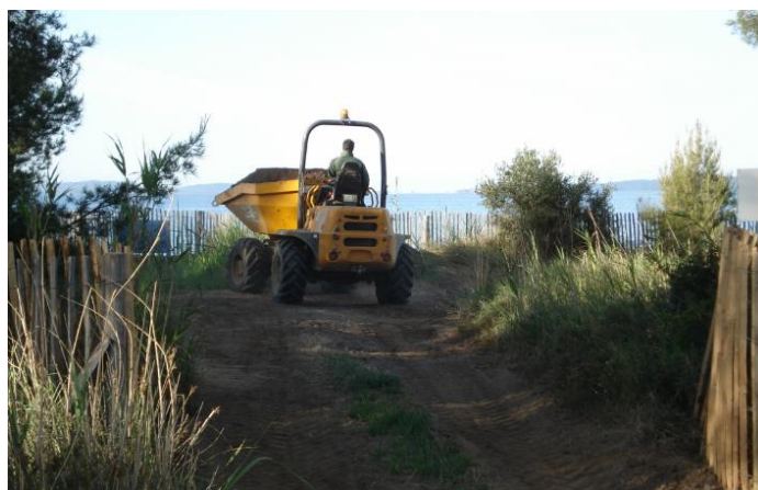
Figura 5: Aggiunta di materiali di ricarica alla linea di costa del Vieux Salins
