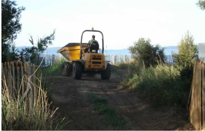
Figure 6 : Apport de matériaux de rechargement sur le littoral des Vieux Salins
