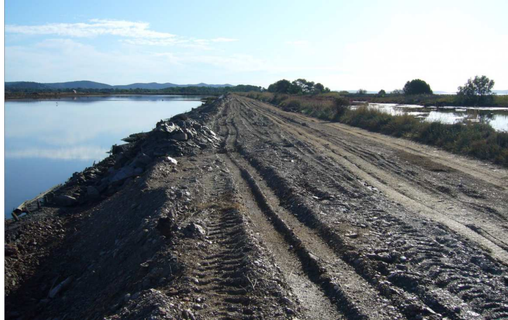
Figure 5 : Réhaussement du talus longeant le canal d'alimentation
