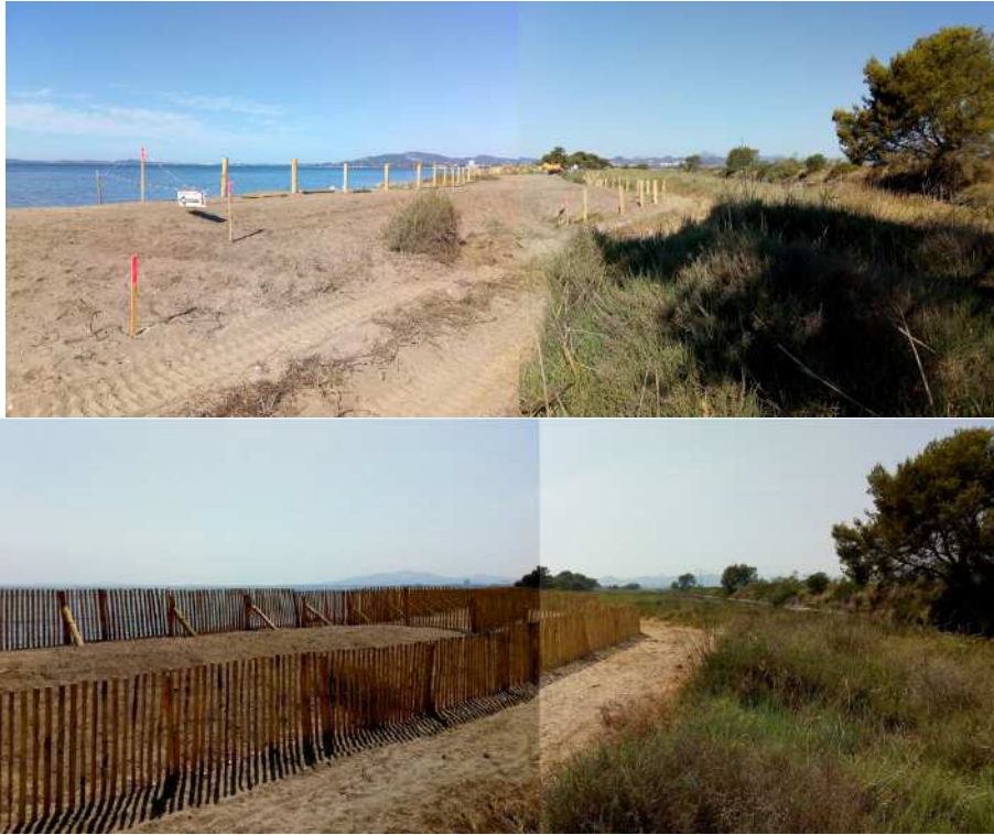
Figure 21 : Evolution du paysage dunaire au point 4 (de haut en bas : avril 2019 avant les travaux ; mai 2019 : après le rechargement ; juin 2019 : installation des ganivelles ; juillet 2019 : à la fin des travaux)
