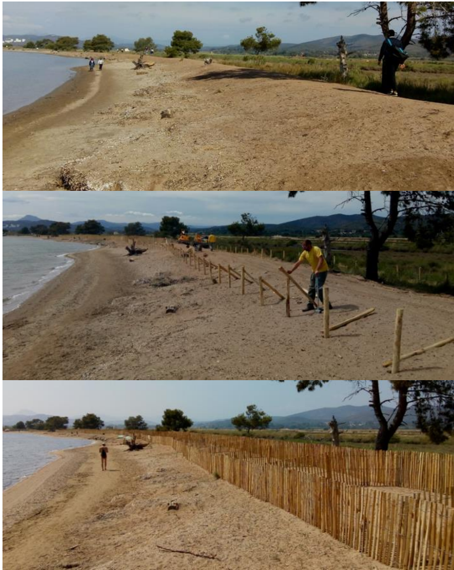
Figura 18: Evoluzione del paesaggio dunale al punto 2 (dall'alto verso il basso: aprile 2019 prima dei lavori; maggio 2019: dopo la ricarica; giugno 2019: installazione delle gru; luglio 2019: a fine lavori)
