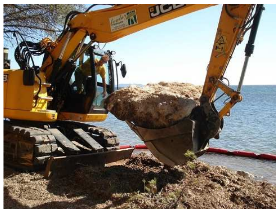
Figure 10 : Dépose des plus gros enrochement du littoral des Vieux Salins
