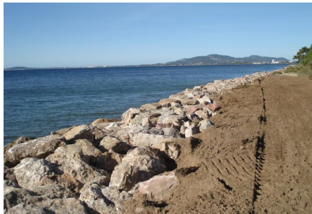
Figura 11: Ricostruzione della roccia a est del sito
