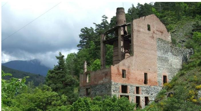
*Vue nord-ouest du four montrant à droite, le prolongement maçonné en pierres du mur du bâtiment, assurant l'accès entre la rampe et la plateforme de chargement. (source non identifiée)*
