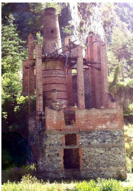
*Vue nord du four montrant la structure de poteaux porteuse de la plateforme en bois au niveau du gueulard, et la construction périphérique. (cliché © Patricia Balandier)*
