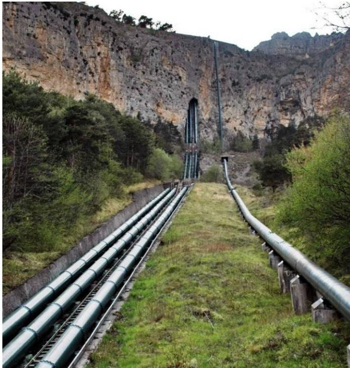
Alimentation de la centrale de Saint-Dalmas de Tende. Vue de la partie haute de la chute. A gauche: les 3 conduites forcées d'origine, et à droite la 4<sup>e</sup> posée par EDF en 1956. (cliché © Michel Royon).
