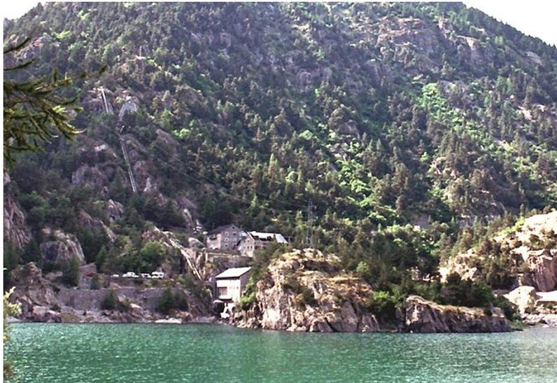
*Vue de l'usine des Mesches au dessus du lac, et de la double conduite forcée alimentée par deux retenues finales, les lacs de Caterino et de la Minière. (source : hydrelect.info)*
