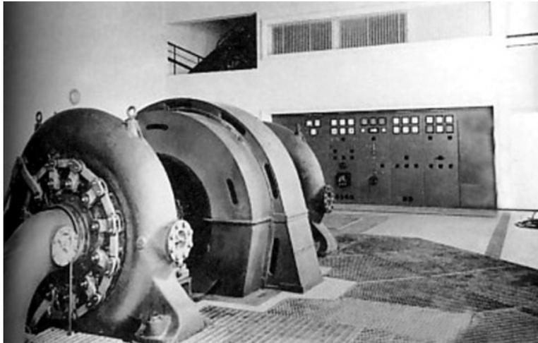
*Centrale des Mesches, un seul groupe entraîné par deux turbines Francis, fonctionnant sous des hauteurs de chute différentes. (source : hydrelect.info)*
