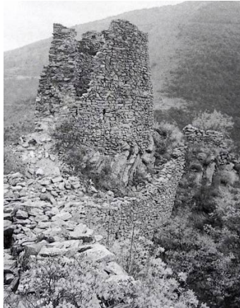
Vue de la tour peu avant sa restauration (Source Le Haut-Pays)
