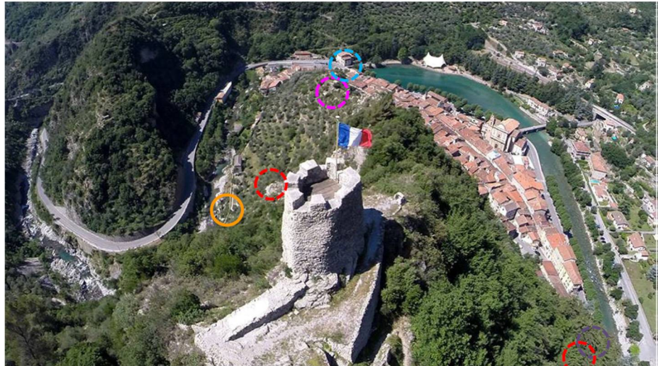
Vue du site de la Cruella et des ouvrages en contrebas. La porte de Turin et la tour secondaire qui la protégeait ne sont plus visibles depuis que la forêt s'est développée sur la pente. (cliché © Vincent Jacques / Drone de regard)
