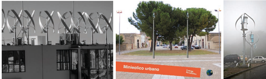
Esempi di installazioni in ambiente urbanizzato
