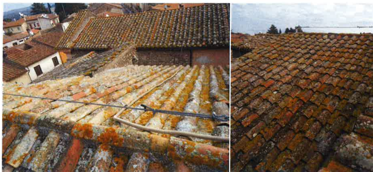
Figura 3 – Vista delle falda di copertura (Est a destra, Ovest a sinistra)
