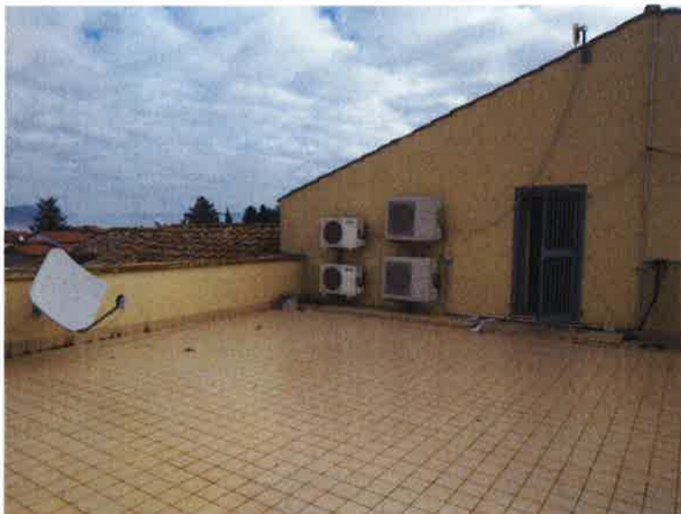
Figura 8 – Terrazzo di accesso alla copertura
