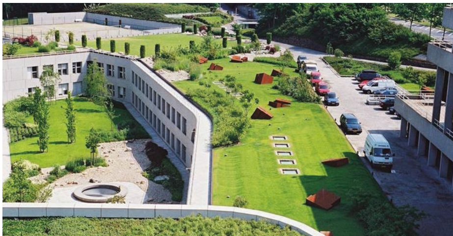
Intervento di mitigazione e adattamento in città – Copertura verde su edifici
