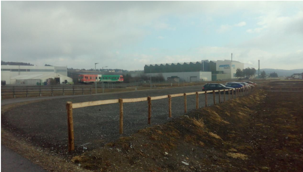
Abbildung 20: Park+Ride Süd als möglicher Standort für einen Mobilitätshub mit Magna Presotec und Andritz Hydro Werk Süd im Hintergrund (Quelle: eigene Aufnahme, 2017)
