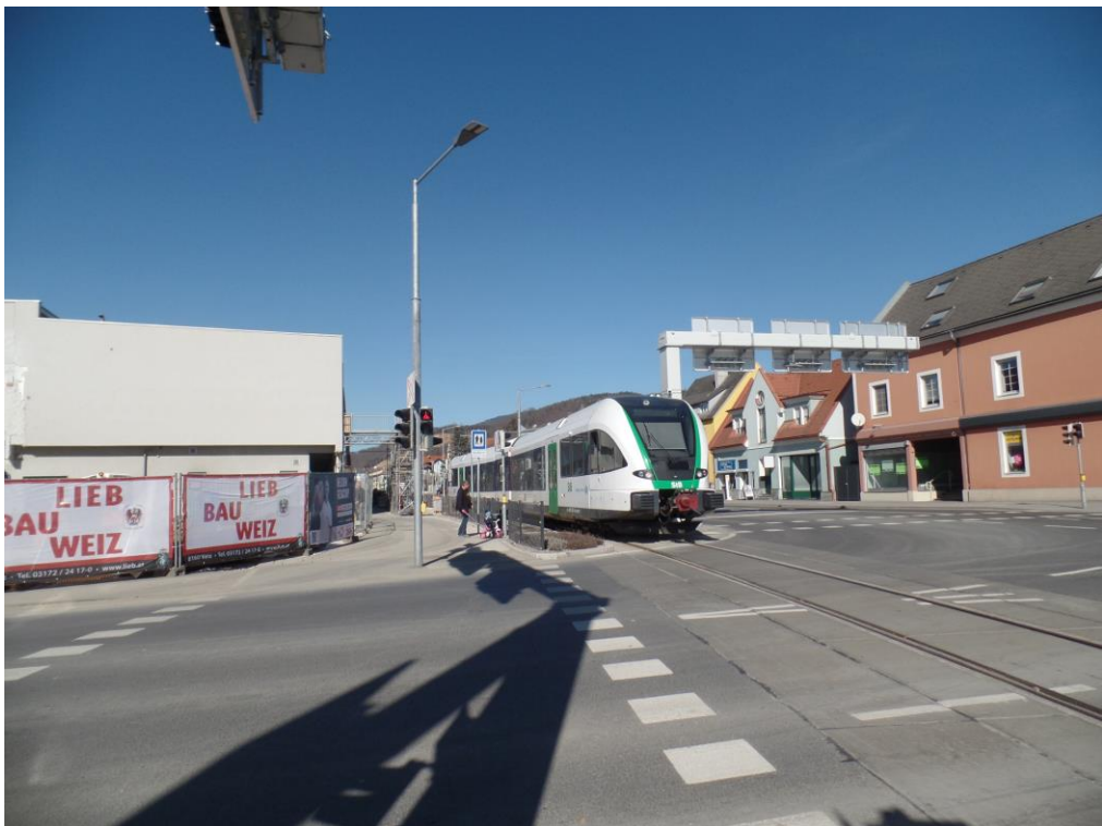
Abbildung 18: Die S31 fährt Richtung Norden vorbei am EKZ "Park's" (Quelle: eigene Aufnahme, 2019)
