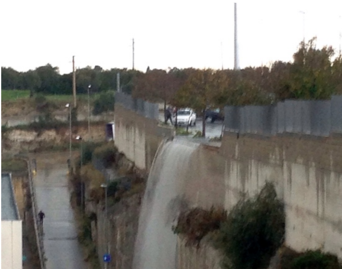
Figure 14: Conséquences de l'évènement du 26 novembre 2015: effondrement du mur à l'arrière du magasin Conforama ( https://bit.ly/2FfxwAh )
