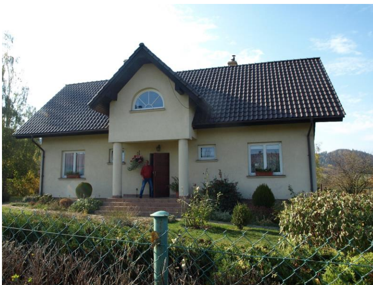
Fot. 1. Boguszów-Gorce. Widok ogólny domu wyposażonego w system geotermii niskotemperaturowej.
