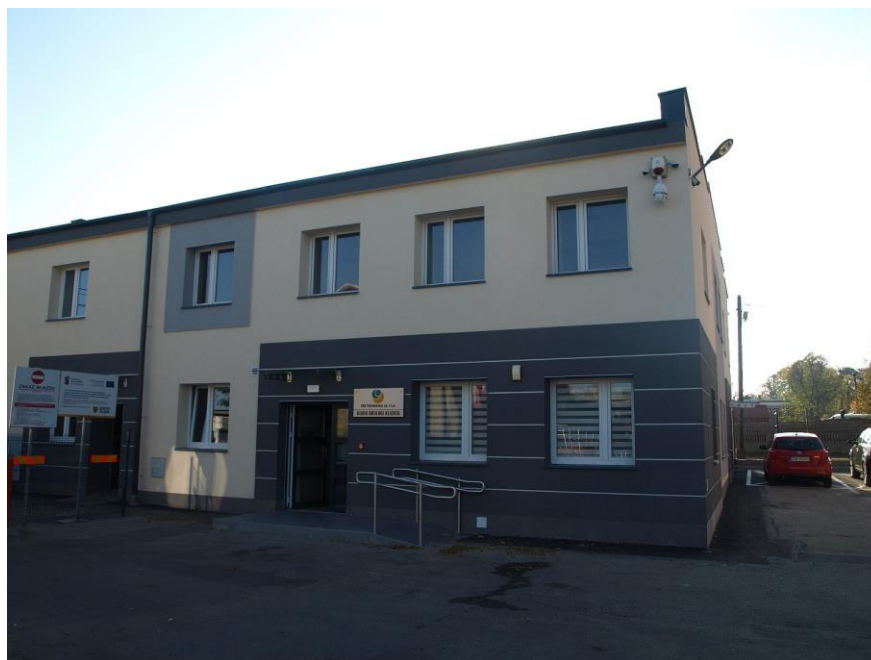
Fot. 11. Budynek biurowo-socjalny Zakładu Gospodarki Komunalnej w Świebodzicach. Widok ogólny obiektu.
