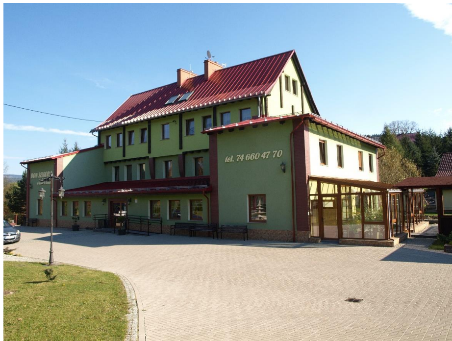
Fot. 7. Dom seniora w Świerkach. Widok ogólny obiektu. Obiekt jest wyposażony zarówno w system geotermii niskotemperaturowej jak i w instalację fotowoltaiczną.
