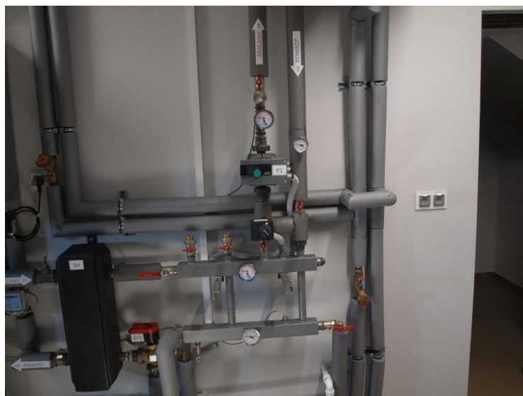
Fot. 13. Instalacja systemu geotermii niskotemperaturowej. Widoczna pompa obiegowa.
