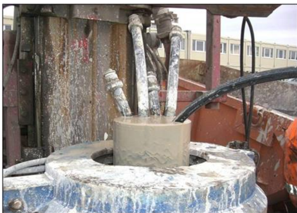
Rysunek 2 Proces cementowania przestrzeni pierścieniowej gruntowych wymienników ciepła (na podst. DPS, 2018)
