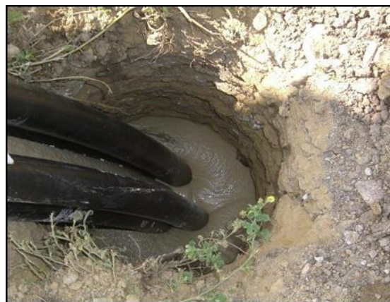
Rysunek 2 Proces cementowania przestrzeni pierścieniowej gruntowych wymienników ciepła (na podst. DPS, 2018)
