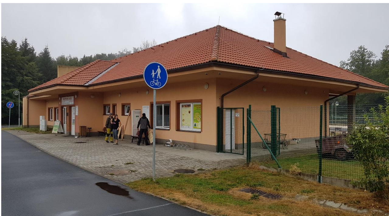
Obr. 9 Objekt sportovního areálu vytápěný tepelným čerpadlem
