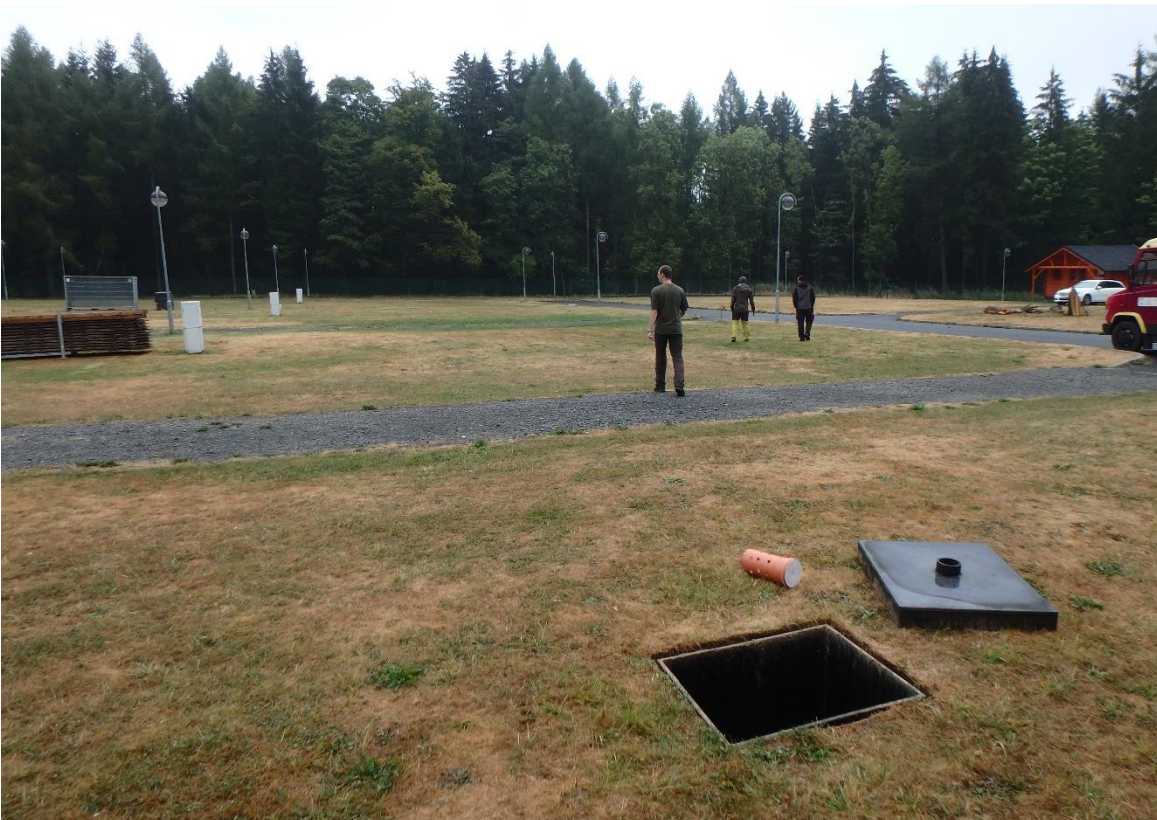
Obr. 11 Vrtky pro tepelné čerpadlo využívané administrativním objektem kempu jsou umístěny pod trávnikem, nedochází tak k žádnému záboru využívané plochy
