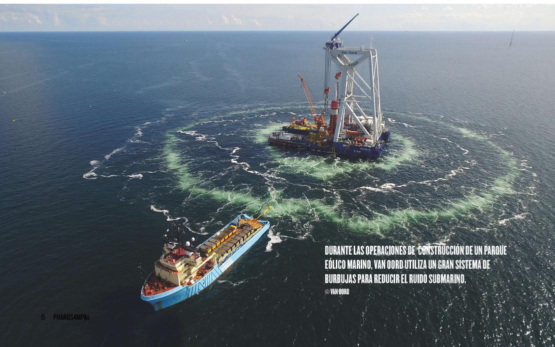
DURANTE LAS OPERACIONES DE CONSTRUCCIÓN DE UN PARQUE EÓLICO MARINO, VAN OORD UTILIZA UN GRAN SISTEMA DE BURBUJAS PARA REDUCIR EL RUIDO SUBMARINO.
