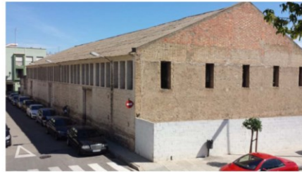
La carpintería exterior de las fachadas se sustituye para reducir el consumo de energía y las emisiones de CO2.
