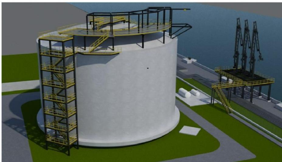
Figure 2 – Réservoir de stockage de GNL et bras de chargement
