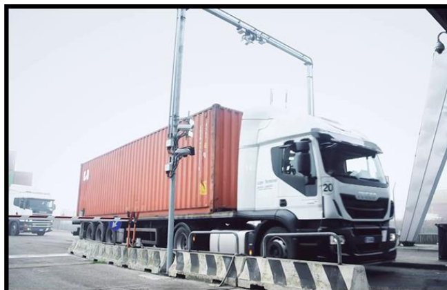
Fig.11 – Passage d'un trailer dans un gate automatisé
