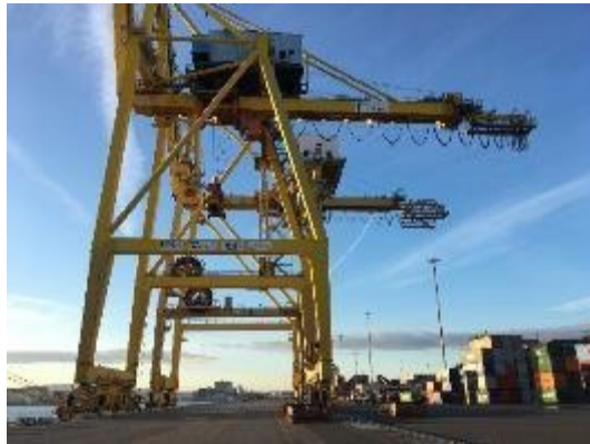
GRU DI BANCHINA GANTRY CRANES
