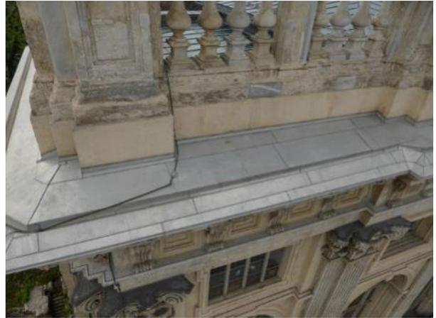
L'aggressione di questi punti piuttosto diffusi consiste nell'assorbimento di acqua all'interno delle matrici lapidee. L'acqua è sia in grado di idratare la matrice cristallina determinandone un aumento di volume (in grado di indebolire la struttura) sia di trasportare all'interno delle porosità sali solubili (in particolare il gesso formatosi per solfatazione dei carbonati a seguito di piogge acide). Il gesso, parzialmente solubile, quando riprecipita può favorire il distacco dei
