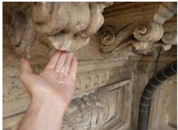
grani di materiale lapideo attraverso la crescita delle neoformazioni cristalline. Da qui l'effetto macroscopico di sfarinamento della pietra visibile in moltissimi punti al di sotto della vecchia faldaleria.
