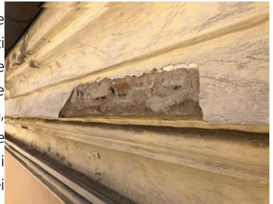
Ritengo questa una delle situazioni più gravi per il peso degli elementi che potrebbero precipitare al suolo e che solo un intervento coordinato tra facciate e tetto può ripristinare una situazione di sicurezza.
