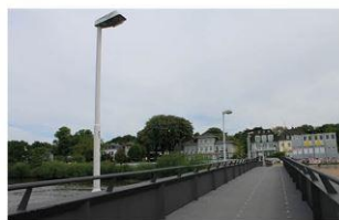
3. Mastleuchten entlang der Brücke
