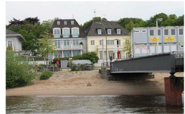
5. Blick vom Steg auf den Teufelsbrück Platz
