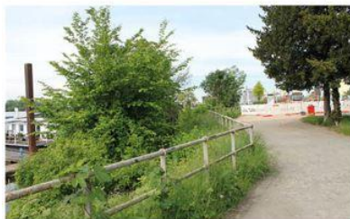
2. Ost-Zugang zum Teufelsbrücker Platz
