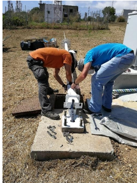
Attività di installazione a Piombino e Castiglione della Pescaia Activités d'installation à Piombino et Castiglione della Pescaia
