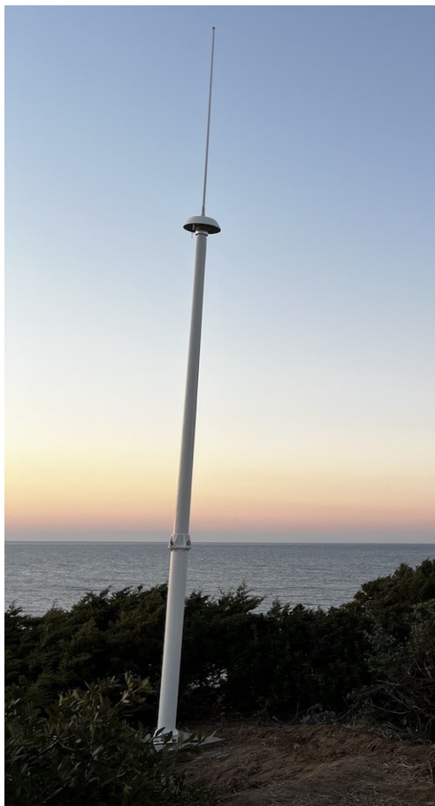
Figura 3. Radar HF Punta Tramontana
