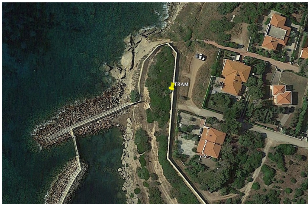
Figura 2: stazione radar HF di Punta Tramontana (Castelsardo, SS)
