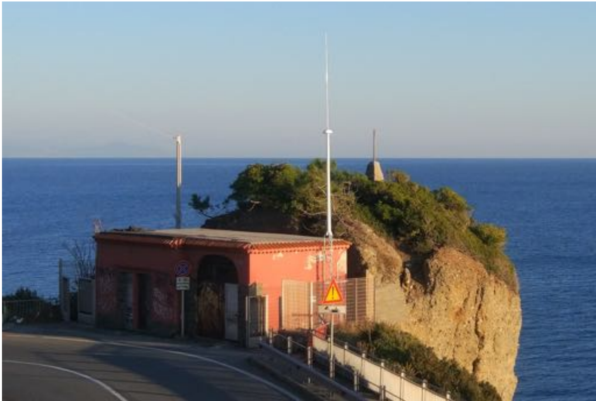
Figura 1: foto del sito di installazione - magazzino ANAS - con l'antenna HF in evidenza; photo du site d'installation - entrepôt de l'ANAS - avec l'antenne radar HF en évidence.
