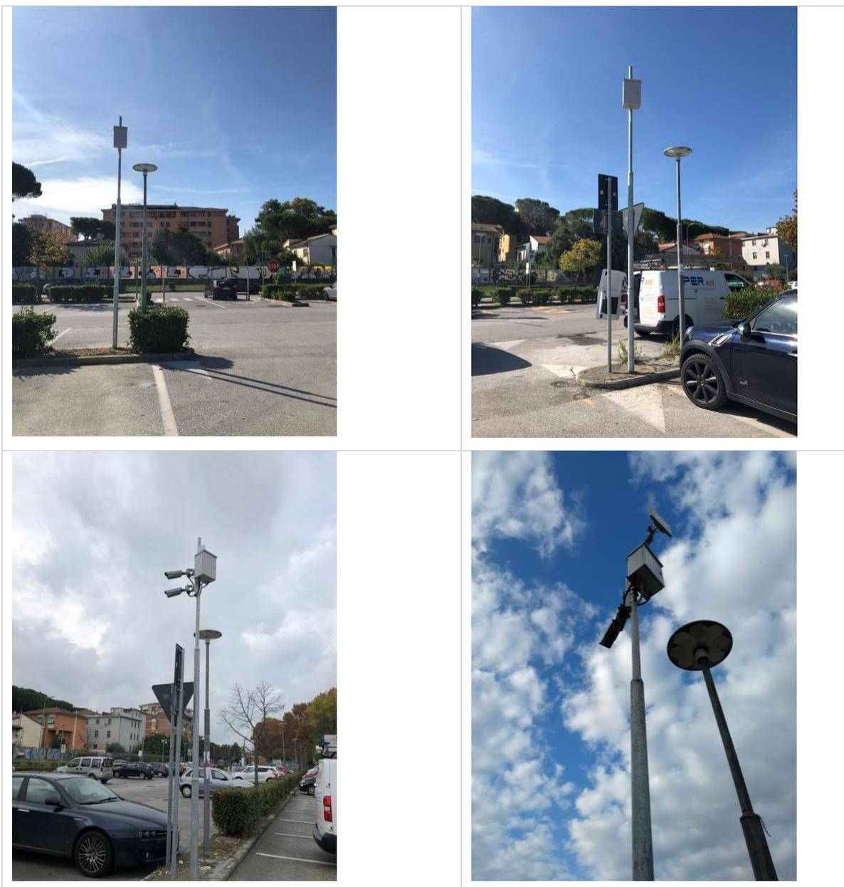
Dans ce cas, il y a deux entrées au parking et deux emplacements différents. Dans les deux cas, une excavation a été réalisée au sol de 80 cm de profondeur sur 50 cm de largeur, renforcée par un treillis électro soudé et un béton coulé pour installer 2 poteaux coniques en fer galvanisé de 6 mètres.
