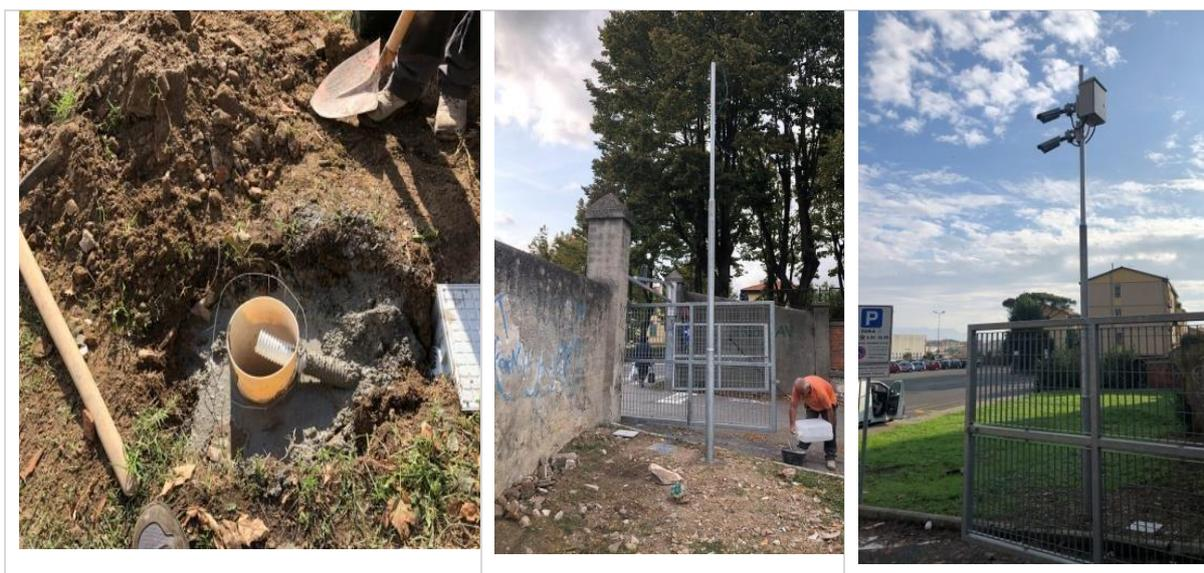
Fouillé au sol de 80 cm de profondeur par 50 cm de largeur, armé de treillis électro soudés et d'une coulée de béton pour installer 1 mât conique en fer galvanisé de 6 mètres.
