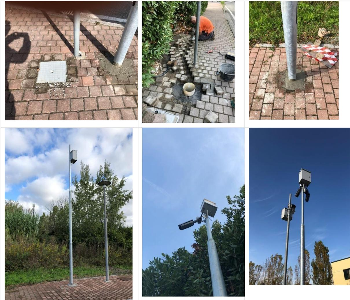
Dans ce cas, il existe trois emplacements différents. Dans les trois cas, une excavation a été réalisée au sol de 80 cm de profondeur sur 50 cm de largeur, renforcée par un treillis électro soudé et une coulée de béton pour installer 3 poteaux coniques en fer galvanisé de 6 mètres.
