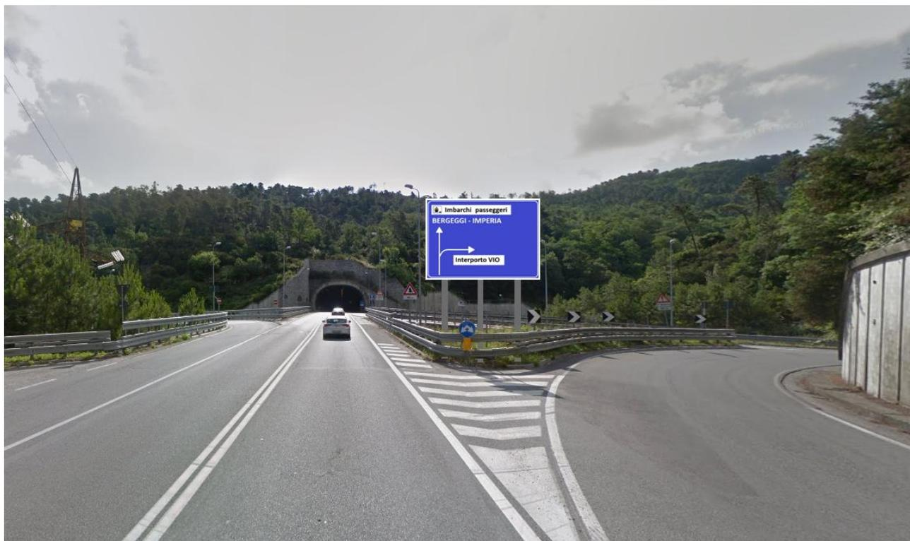
Fig. 8. Position du PMV2, près de la jonction «au trompette». Le code de la route précise que le PMV2, situé côté route, doit avoir une distance minimale de 30 cm du bord extérieur du quai; tandis que les trois supports verticaux du PMV2 doivent avoir été placés à au moins 50 cm du bord extérieur du quai.
