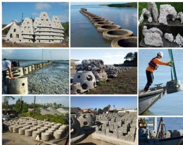
**Fig. 7. Barriere artificiali realizzati con gusci di ostrica**
