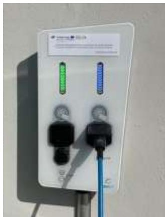
Grazie al progetto RUMBLE, oggi il Porto di Bastia (Corsica, Francia) è dotato di quattro colonnine per la ricarica di veicoli elettrici (di tipo Kino® PRO) capaci di ricaricare fino a 8 veicoli elettrici. La stessa tipologia di colonnina è stata installata nel Porto de l'Ile Rousse (possibilità di ricaricare fino a 2 veicoli).
