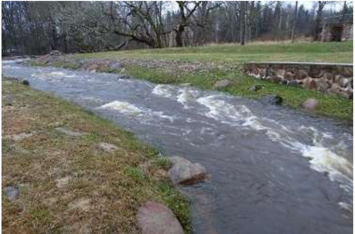
Foto 5. Kalapääsu alumises osas on paiguti voolurahustuskive liiga vähe ning vool seetõttu väga kiire. Puuduvad kalade varjupaigad (R. Järvekülg, 10.12.2019).
