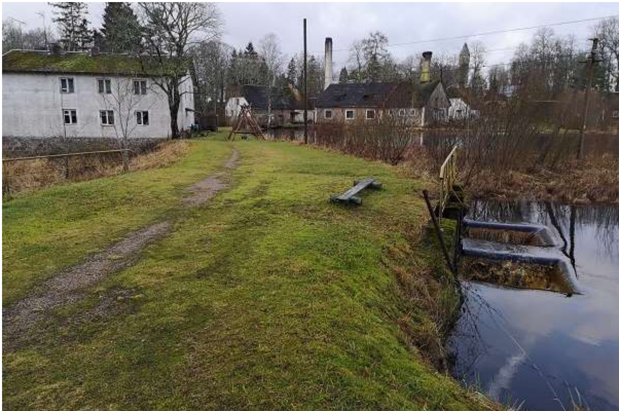
Foto 24. Taagepera paisu liigveelaskmeks on kaheosaline šahtkaev (R. Järvekülg, 08.12.2019).
