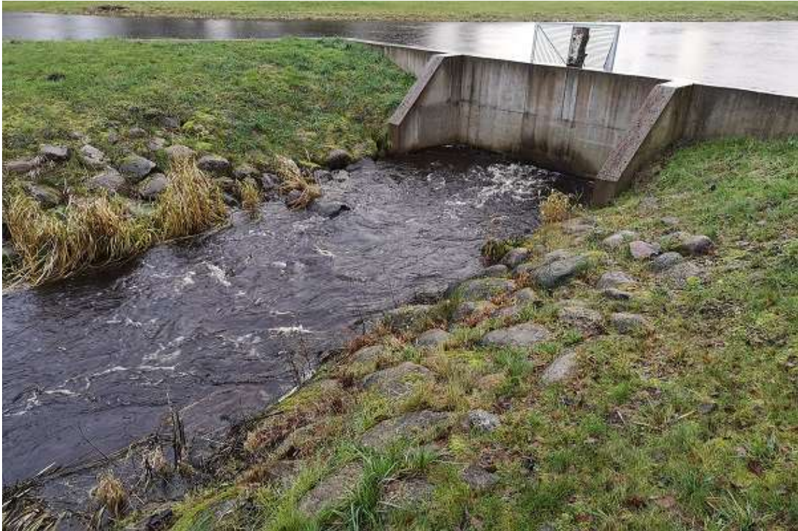
Foto 9. Kalapääsu sissevoolu regulaator on praegu probleemseks kohaks. Vaatluspäeval (08.12.2019) oli veetasemete vahe regulaatori ala- ja ülavee vahel ca 25 cm. Veevool läbi regulaatori põhjaava oli survealine ja voolukiirus avas suur. Kaladele on regulaatori ava hästi läbitav, kui veeaste regulaatori ala- ja ülavee vahel oleks \leq 10 cm. Paisjärve NPT-d tuleks alandada (R. Järvekülg).
