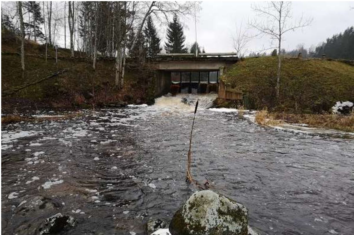
Foto 16. Vaade Saarlase paisule alavee poolt. Vaatluspäeval oli paisutuskõrgus 2,45 m ning ülaveetase oli ca 0,5 m allpool tavapärast taset (R. Järvekülg, 10.12.2019).
