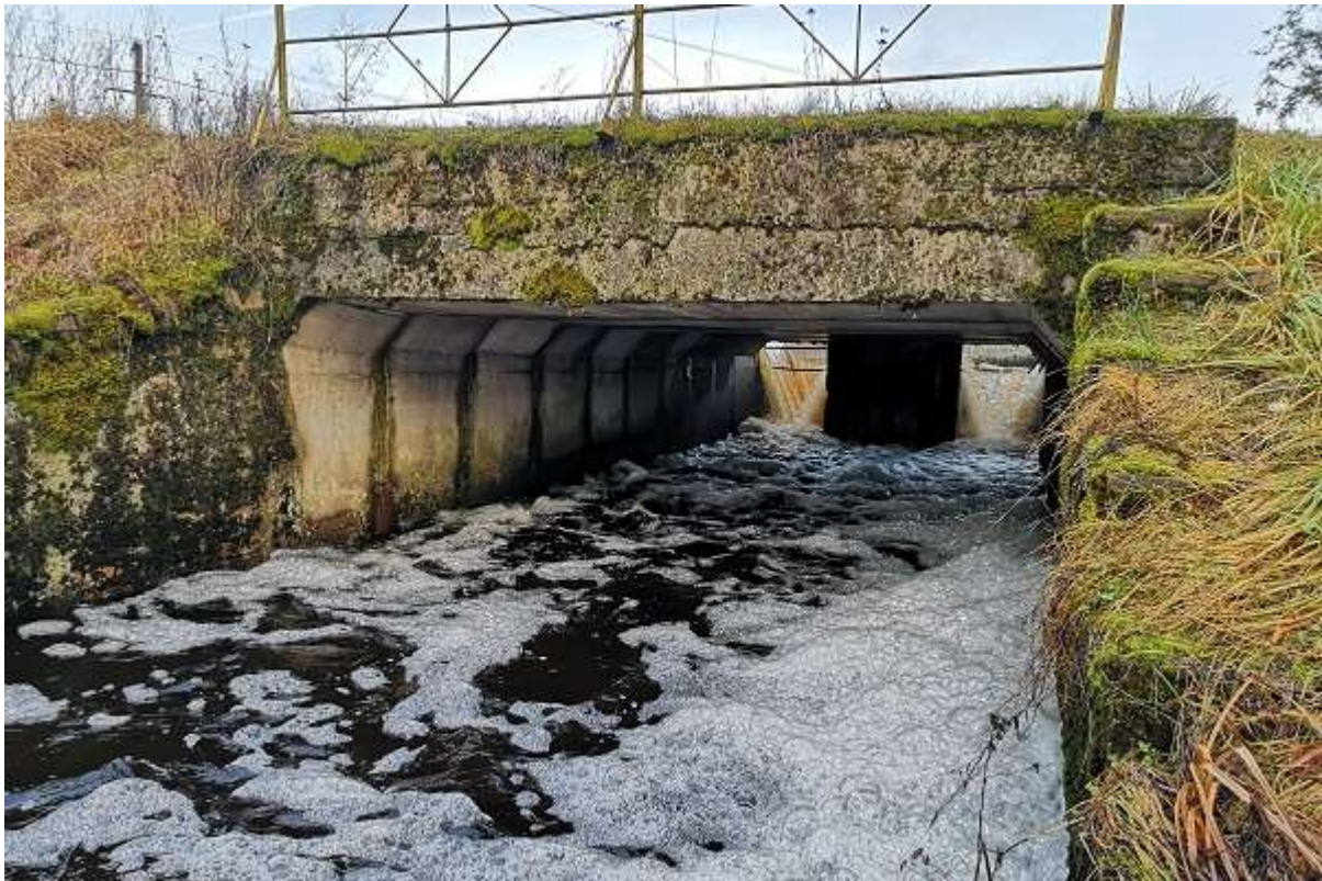
Foto 26. Vaade liigveelaskmele alavee poolt (R. Järvekülg, 08.12.2019).
