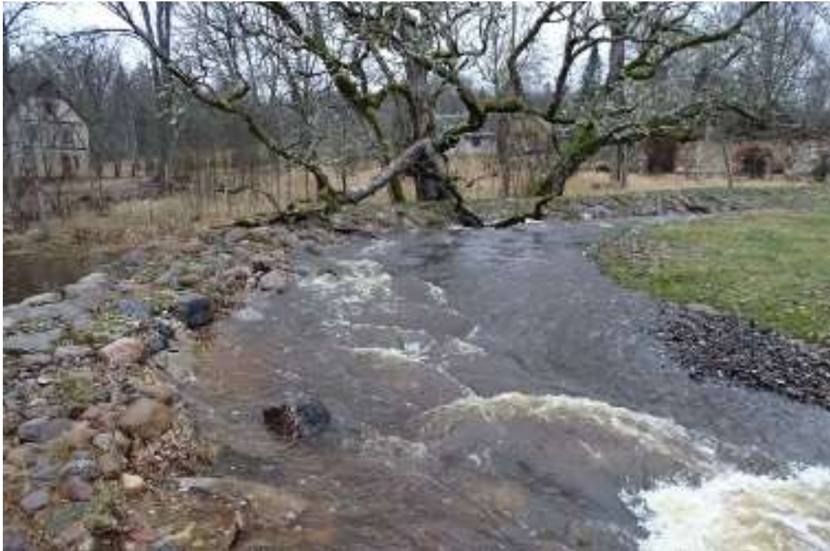
Foto 6. Lokaalselt suurema languga ning väheste voolurahustuskividega on ka kalapääsu lõik, kus kalapääsu säng teeb tagasipöörde paisu poole (R. Järvekülg, 10.12.2019).
