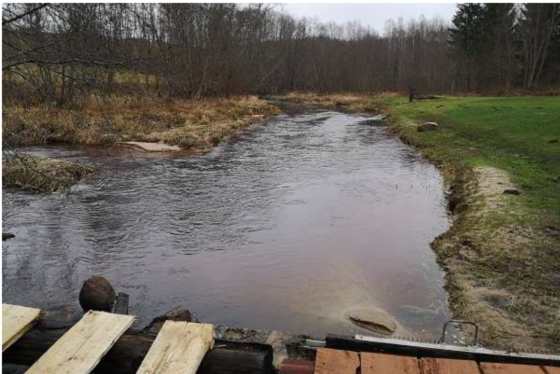
Foto 10. Vaade paisult ülesvoolu paisutusosalale. Kaldavööndi järgi on näha, et tavapäraselt on veetase olnud ca 0,5 m kõrgemal vaatluspäeva omast. Paisutusala ilmet see aga oluliselt ei muuda. Paisjärve pole, on vaid paisutatud jõe osa (R. Järvekülg, 10.12.2019).
