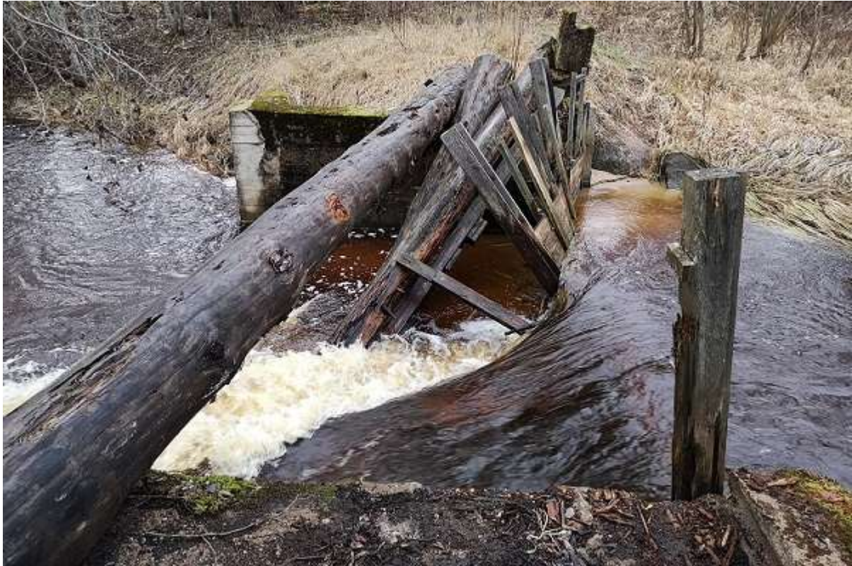
Foto 11. Paisu liigveelask on lagunenenud. Lip-lipi, lap-lapi peal konstruktsioon pole vee survele vastu pidanud. Tõenäoliselt on paisu omanik jäänud hiljaks paisu varjade eemaldamisega jõe veetaseme kerkides (R. Järvekülg, 10.12.2019).
