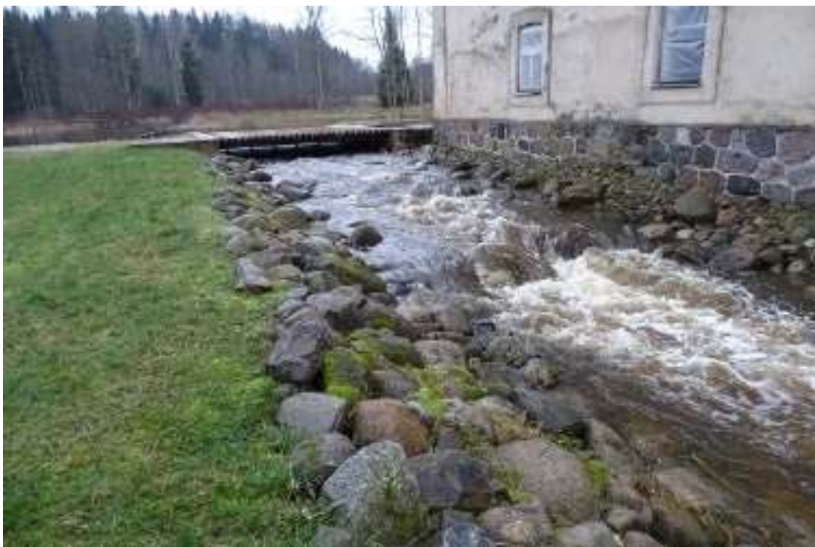
Foto 8. Kalapääsu ülaosas vajab korrigeerimist voolurahustuskivide paigutus. Tekkinud on veeaste, mida saab hajutada voolurahustuskive ümber paigutades (R. Järvekül, 10.12.2019).
