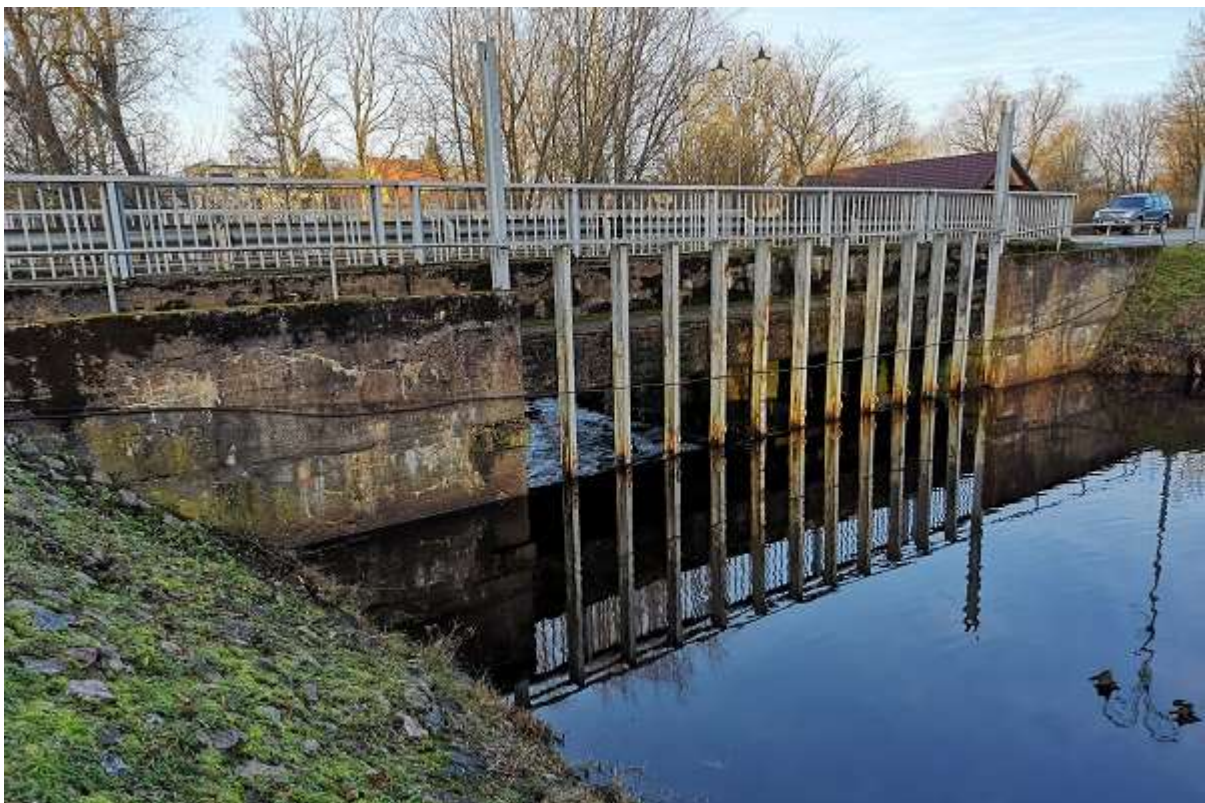
Foto 2. Tõrva paisu liigveelask vaatega ülavee poolt. Liigveelasu juures peaks olema mõõdulatt paisjärve veetaseme hindamiseks (R. Järvekülg, 08.12.2019).
