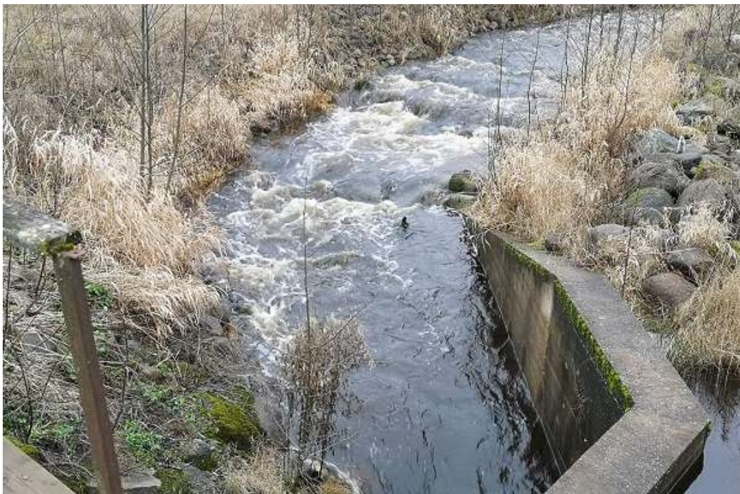
Foto 5. Sänna Mäeveski kalapääsu alumine osa silla alla sisenemisel ja vahetult enne silda on väga suure languga ning algselt sinna paisutatud voolurahustusrahnud on nihkunud paigast. Seetõttu on vool paiguti väga kiire ja rändetingimused kaladele ebasoodsad (R. Järvekülg, 10.12.2019).
