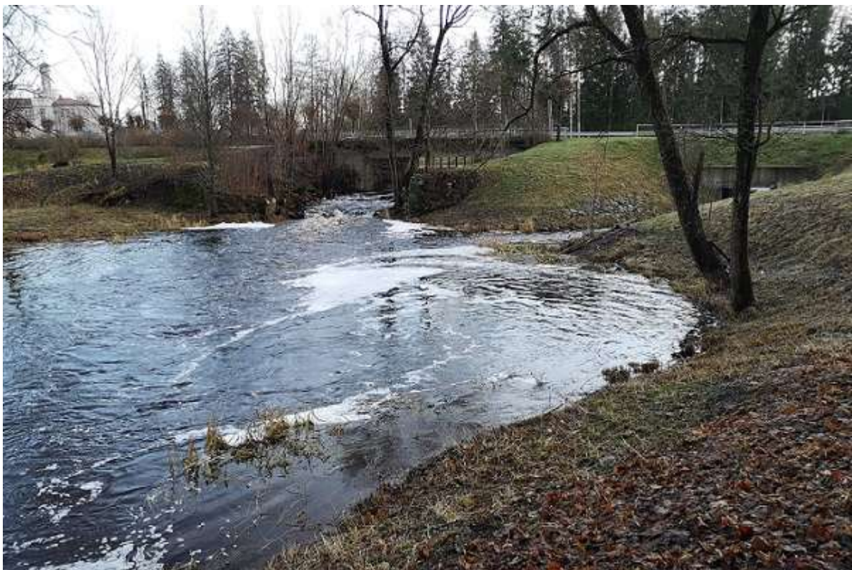
Foto 4. Liigveelasu äravool (ülal vasakul) ja kalapääsu väljavool (ülal paremal) asuvad lähestikku. Tõusval rändel olevatel kaladel on kalapääsu leidmine lihtne (R. Järvekülg, 08.12.2019).
