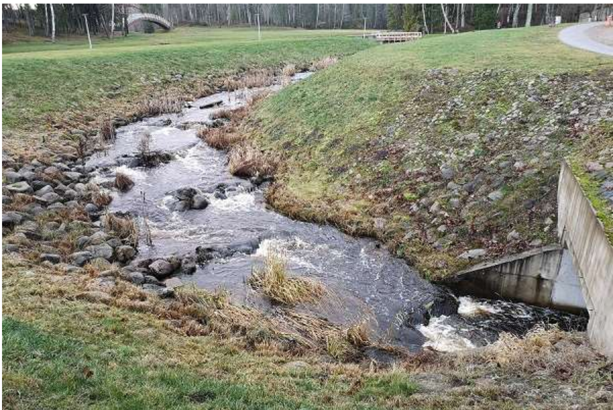
Foto 6. Probleemne koht kalapääsus on vahetult paisust (Veski tänava sillal) ülesvoolu jääv lõik, kus lang on ülejäänud kalapääsuga võrreldes suurem ning kivilävendite veeastmed erineva languga. Lõik vajab korrigeerimist (R. Järvekülg, 08.12.2019).
