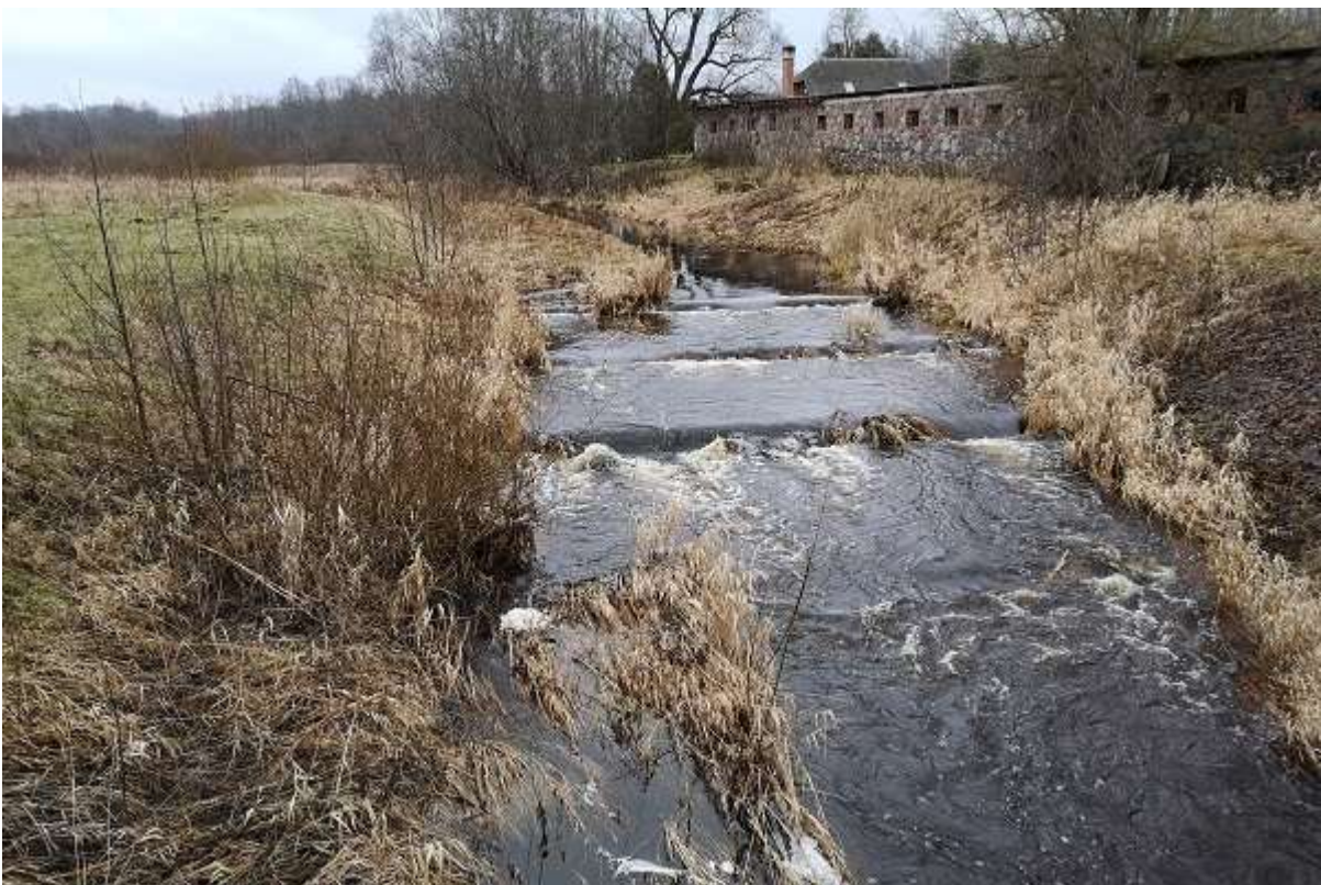
Foto 2. Jõe vasak haru on kujundatud kolme veeastmega kalapääsuks (R. Järvekülg, 10.12.2019).
