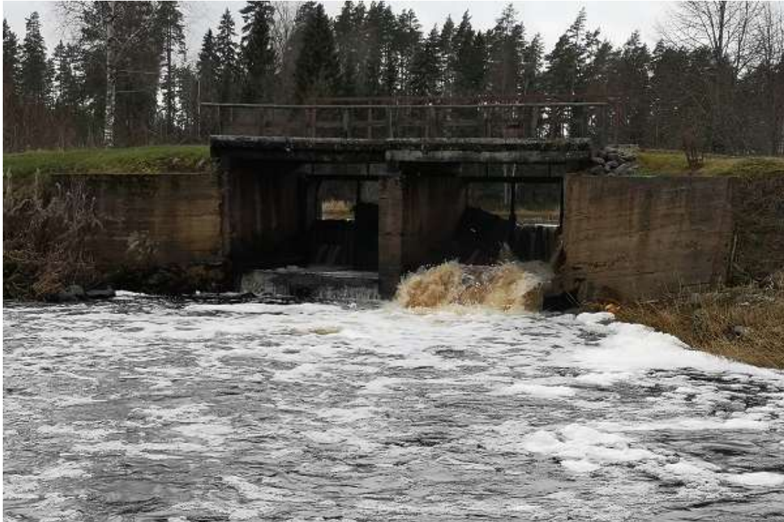
Foto 18. Dzirnavase paisu paisutuskõrgus on ca 2,1 m. Suurvee ajal on osa varjasid eemaldatud ja paisutustase madalam. Vaatluspäeval oli varjadega avatud vaid vasak liigveelaskme osa. Paisu omanikule on mureks ootamatud Holdre paisu avamised, misjärel Dzirnavase paisul tekib uputusohht (R. Järvekülg, 08.12.2019).
