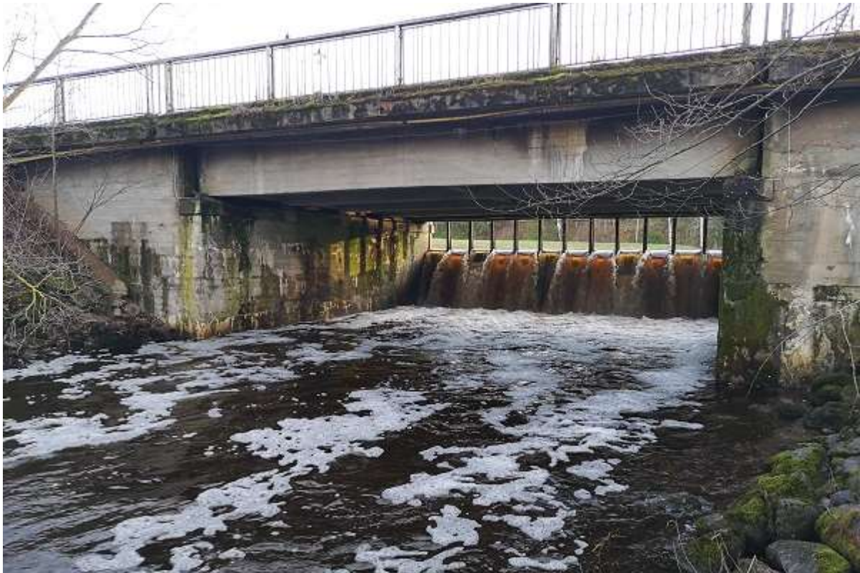
Foto 3. Tõrva paisu liigveelask alavee poolt. Kalade laskuv ränne liigveelasu kaudu on ohutu, sest liigveelasu all on piisav veetäide (R. Järvekülg, 08.12.2019).
