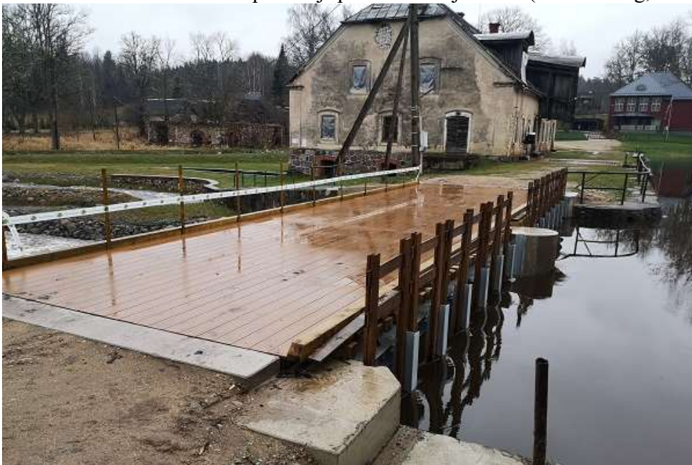
Foto 2. Vastse-Roosa paisu liigveelask (R. Järvekülg, 10.12.2019).
