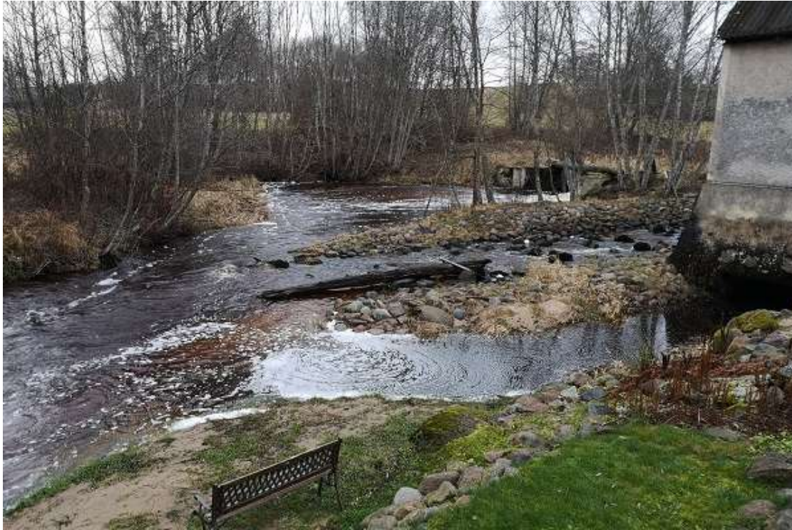
Foto 12. Vaade paisu poole alavee poolt. Vasak haru (fotol all) on HEJ 5 väljavoolukanal, keskel on kalapääsu alumine osa ning parem haru (fotol üleval) tuleb liigveelasu juurest (R. Järvekülg, 10.12.2019).
