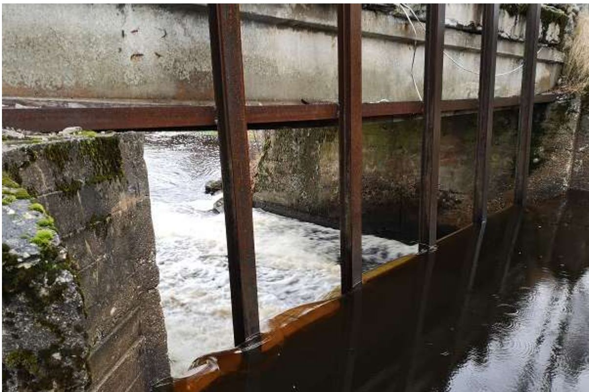
Foto 17. Vaade paisu liigveelaskmele ülavee poolt. Liigveelaskme tehniline seisund on hea (R. Järvekülg, 10.12.2019).
