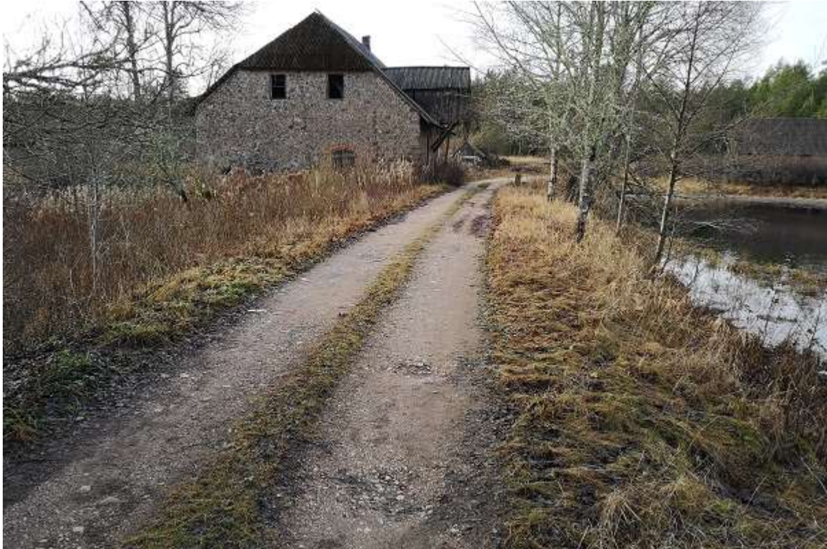
Foto 20. Holdre pais on rajatud madalale laiale jõe lammile ning seetõttu ulatub pinnaspaisu pikkus mitmesaja meetrini. Esiplaanil vana veskihoone (R. Järvekülg, 08.12.2019).
