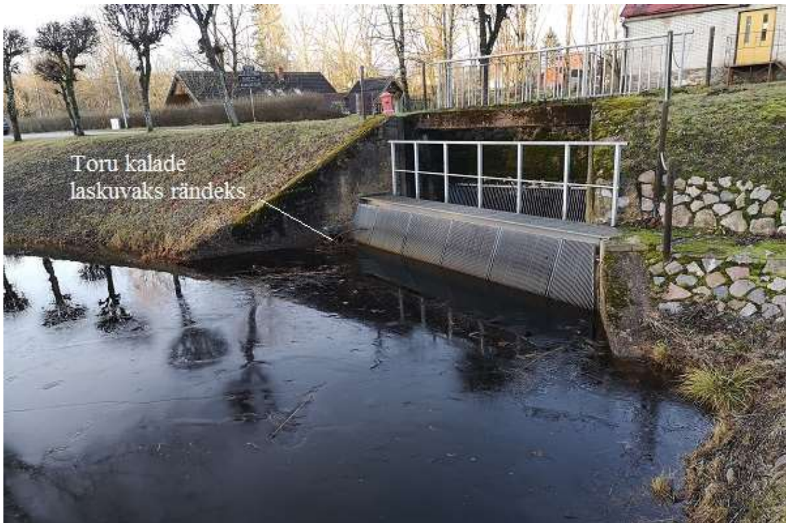
Foto 10. HEJ sissevoolul on suhteliselt korralik võre keskmiste ava läbimõõtudega 20...21 mm. Mõnes kohas on võre veidi deformeerunud ning seal on avad vahemikus 13...26 mm. Võrede juures on ka toru ( \varnothing 0,5 m) kalade laskuva rände võimaldamiseks (R. Järvekülg, 08.12.2019).
