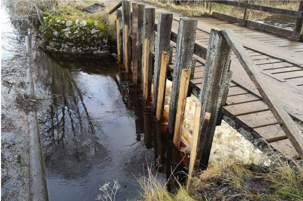
Foto 22. Paisu liigveelase on kehvast seisundis, veetaseme reguleerimine toimub siis kui keegi selleks aega saab, ka liigveelaskme parandamine meenutab „lip-lipi peal, lap-lapi peal“ tehnoloogiat (R. Järvekülg, 08.12.2019).
