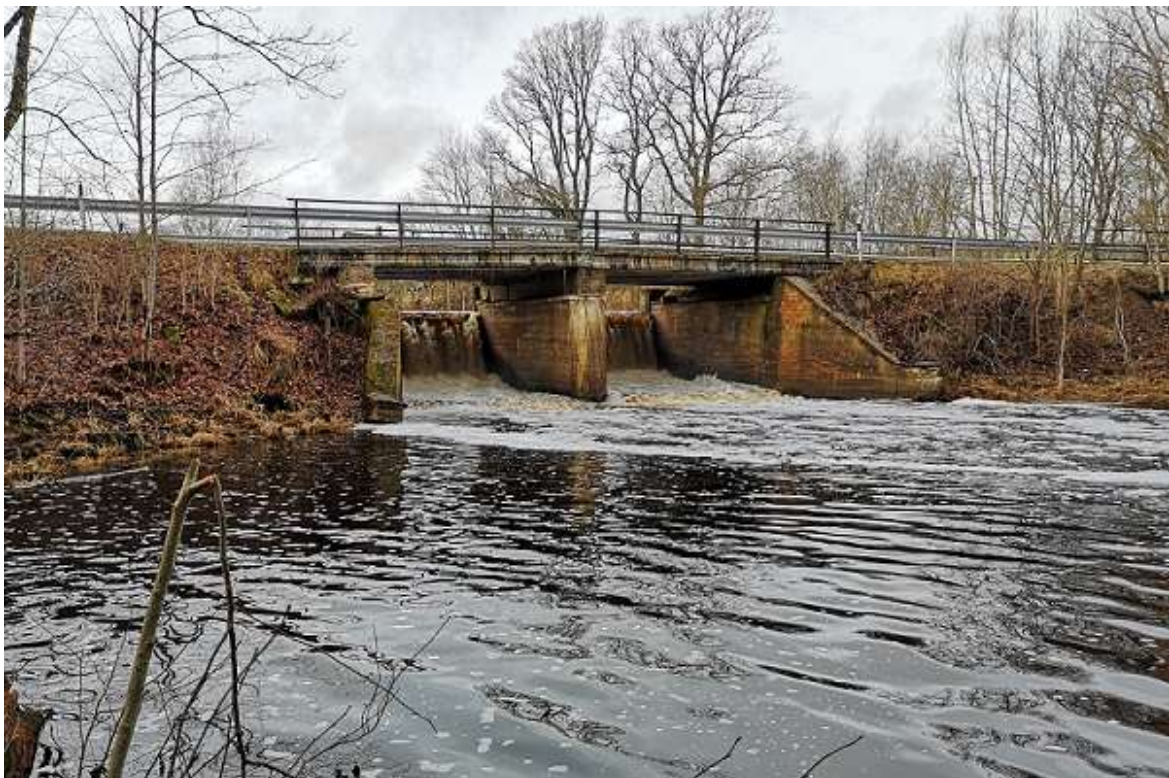
Foto 12. Vaade Koorküla paisule alavee poolt. Paisu kõrgus on ca 2,7 m. Praeguse paisutustaseme juures on kalapääsu rajamine äärmiselt keeruline, töömahukas ja kallid. Mõistlikeks lahendusteks oleks kas paisu lammutamine või paisutuskõrguse alandamine 1,5 m-le ning seejärel kärestikulise möödaviikpääsu rajamine jõe vasakule või paremale kaldale (R. Järvekül, 08.12.-2019).
