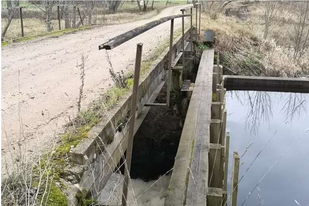
Foto 4. Nagu puitvarjadega paisude puhul sageli, nii tuleb ka Sänna Mäeveski paisul varjade eemaldamiseks ja lisamiseks turnida kahel prussil. Ohutuspiirded puuduvad. Kui vajadus varjade eemaldamiseks peaks tekkima talvel, kui prussid on jäätunud ja libedad, siis ega keegi neid varjasid sealt paisult eemaldama ei pruugi minnagi. Just seetõttu rikkus varakevadine tulvavesi 2012. aastal valminud kalapääsu 2013. a algul ära. Hiljem kalapääs küll taastati, kuid mitte enam algse kvaliteediga (R. Järvekülg, 10.12.2019).
