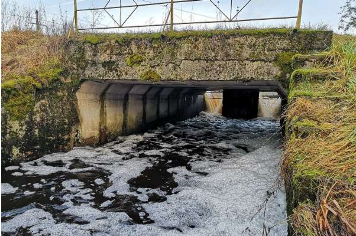
Foto 26. Vaade liigveelaskmele alavee poolt (R. Järvekülg, 08.12.2019).
