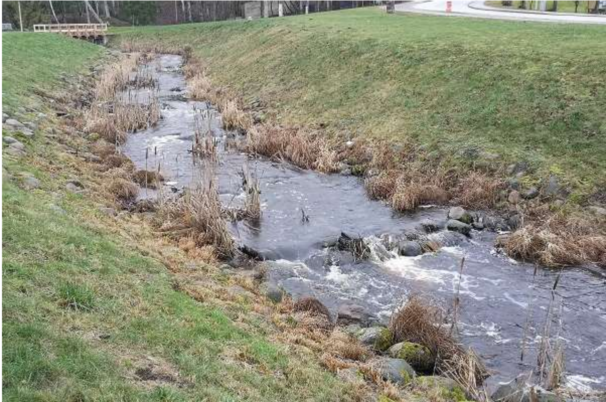
Foto 7. Tõrva kalapääsu keskosa, sissevoolu ja Veski tänava vahel. Sellel lõigul on kalade rändetingimused rahuldavad kuni head, kuid mõned kivilävendid vajaksid siiski korrigeerimist (R. Järvekülg, 08.12.2019).
