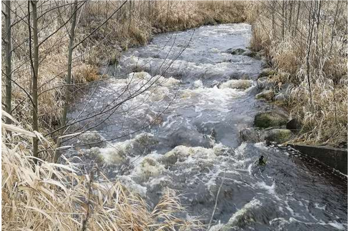
Foto 6. Ka kalapääsu keskosa on ebahühtlase languga ja voolurahustuskivide reas vajavad korrigeerimist (R. Järvekülg, 190.12.2019).
