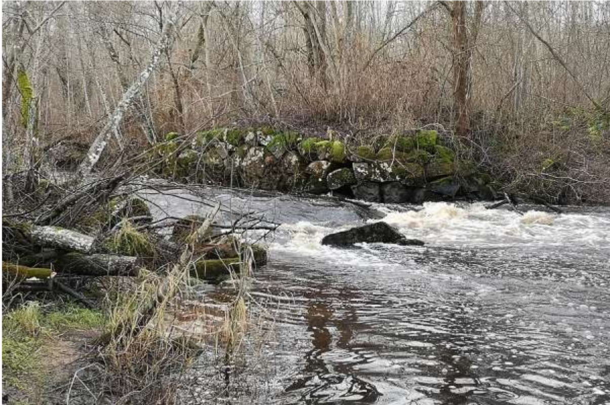
Foto 15. Paisuvare Jeti–Kiinimäe teest ca 50 m allavoolu. Vaatluspäeval oli vare paisutuskõrgus 0,5 m. Madalvee tingimustes on vare paisutuskõrgus oluliselt suurem. Vare takistab kalade rännet (R. Järvekülg, 08.12.2019).
