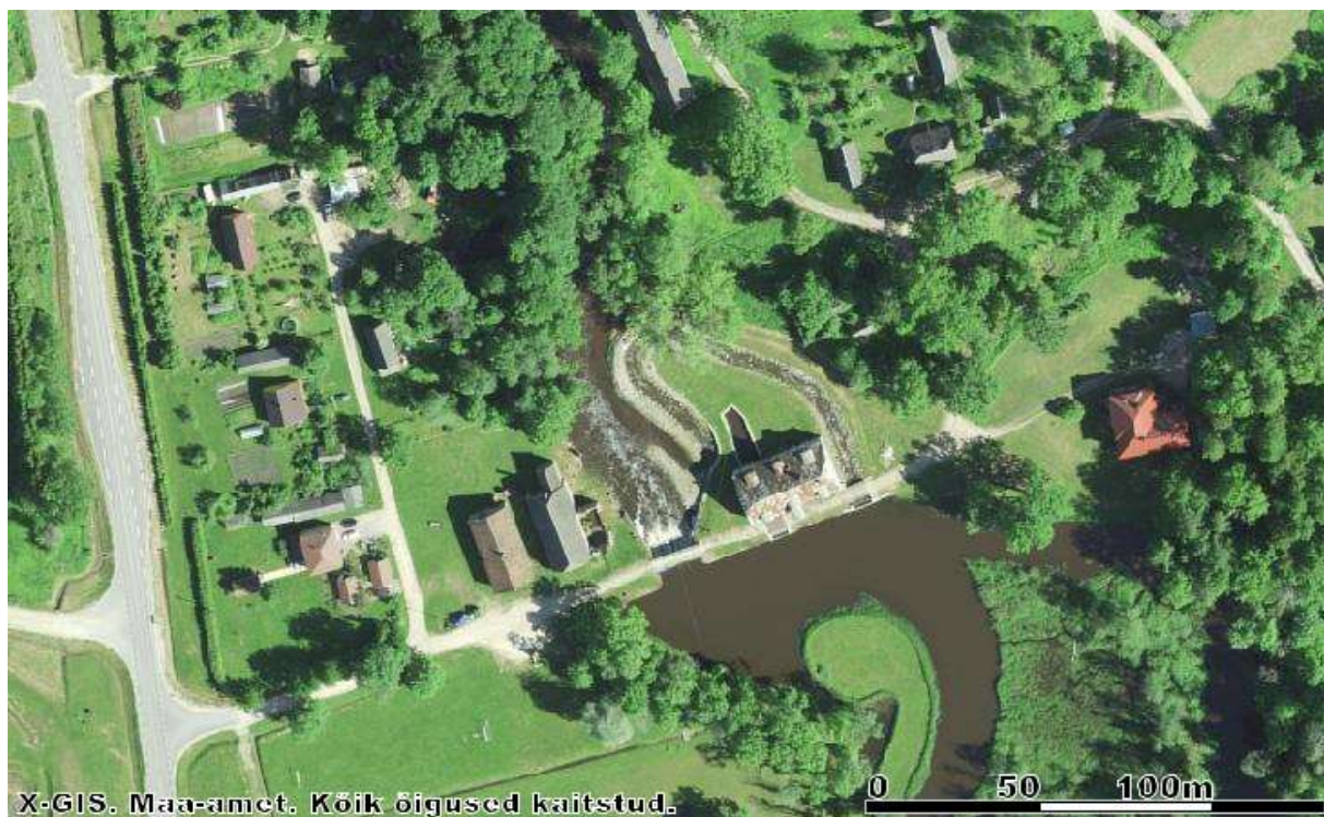
Joonis 2. Vastse-Roosa pais ortofotol. Vasakul laiemal harul asub liigveelask, keskel HEJ hoone kohal turbiinikanali sisse- ja väljavool (väljavoolukanal jätkub pärast ca 15 m maa-aluse toruna kuni jõeni) ning paremal kitsama haruna on kalapääs, mis suubub jõkke parkümmend m allpool liigveelasku.
