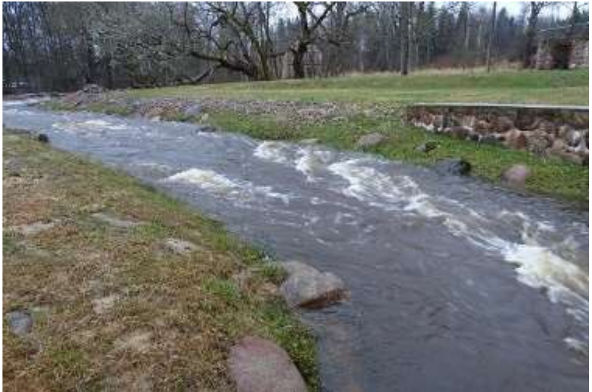
Foto 5. Kalapääsu alumises osas on paiguti voolurahustuskive liiga vähe ning vool seetõttu väga kiire. Puuduvad kalade varjupaigad (R. Järvekül, 10.12.2019).
