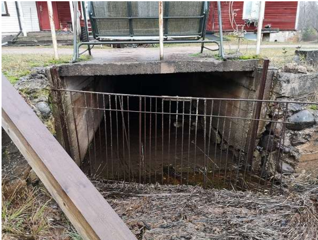
Foto 18. Varem on Saarlase paisu juures töötanud HEJ turbiini veetarbega ca 0,8 m 3 /s. Omaniku sõnul rikkus turbiini sinna sattunud puunott. Turbiini sissevoolu ees on võre, mille algsed avad on olnud 5...7 cm, pärast loodusjõudude toimet on aga avad suurenenud kuni 15 cm-ni. On selge, et selline võre ei takistanud turbiini sattumast mitte ühtki kala, ega toimunud kuigi efektiivselt ka prahitökkena (R. Järvekülg, 10.12.2019).
