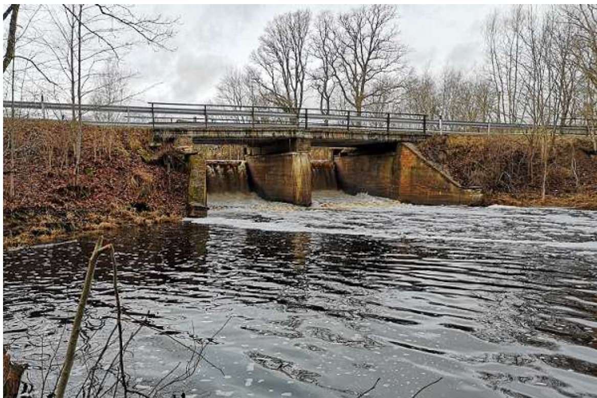
Foto 12. Vaade Koorküla paisule alavee poolt. Paisu kõrgus on ca 2,7 m. Praeguse paisutustaseme juures on kalapääsu rajamine äärmiselt keeruline, tömahukas ja kallis. Mõistlikeks lahendusteks oleks kas paisu lammutamine või paisutuskõrguse alandamine 1,5 m-le ning seejärel kärestikulise möödaviikpääsu rajamine jõe vasakule või paremale kaldale (R. Järvekül, 08.12.-2019).
