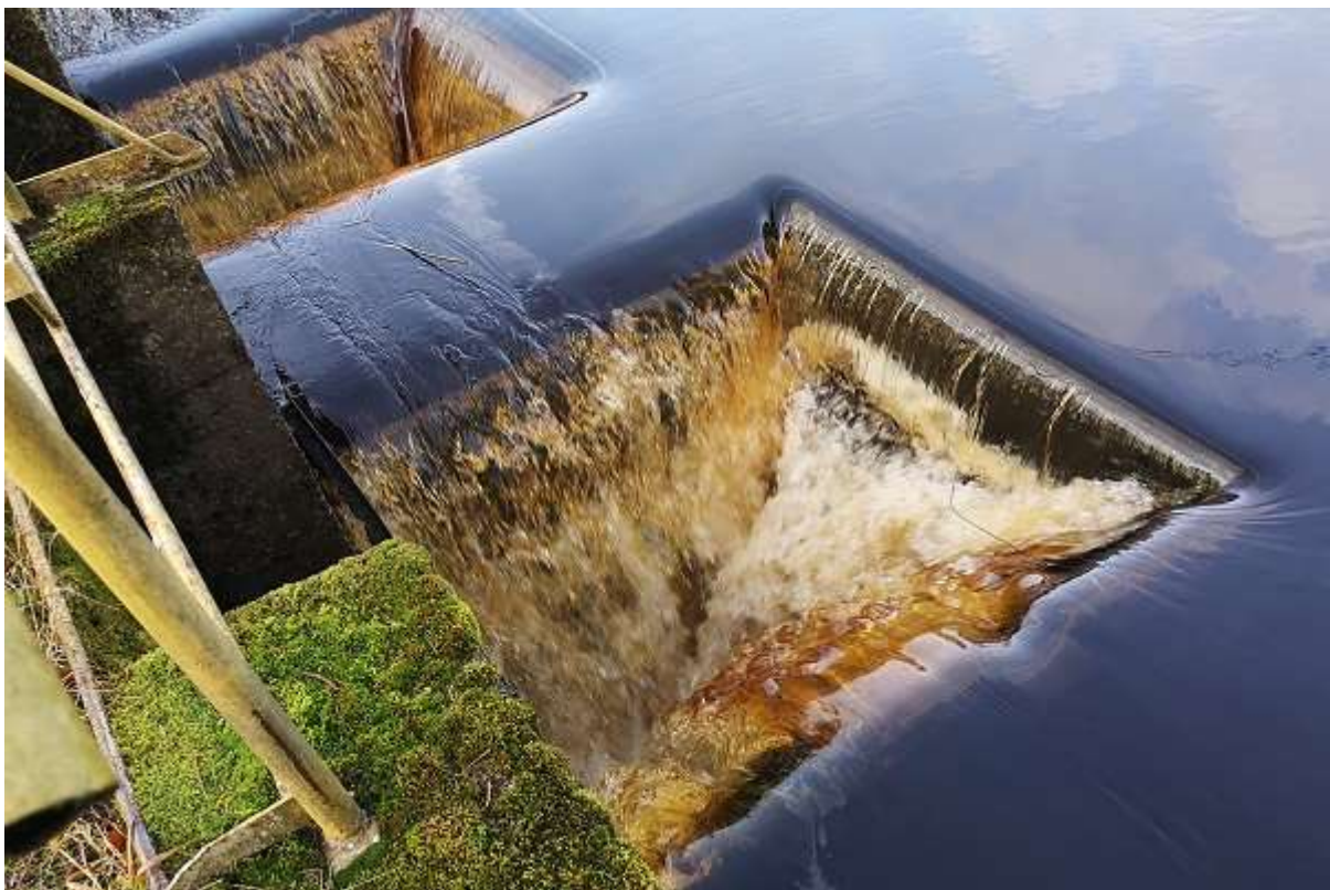
Foto 25. Vaade šahtkaevude sissevooludele (R. Järvekülg, 08.12.2019).
