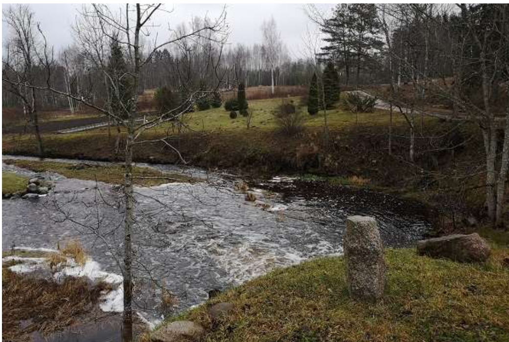
Foto 19. Kalapääsu rajamise teeb keeruliseks see, et jõe kaldad on paisu juures kõrged ning järsud. Vaade paisult jõe paremale kaldale. Kalapääsu rajamine on võimalik, kui alandada ülavee taset 3 m-lt 2 m-le. Paisu omanik on oma sõnul toimiva kalapääsu lahenduse leidmisest huvitatud ning valmis alandama praegust paisutustaset (R. Järvekülg, 10.12.2019).
