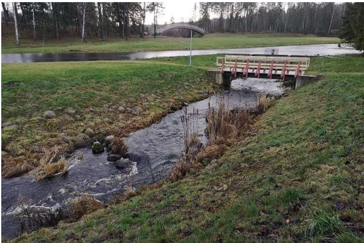
Foto 8. Kalapääsu ülemises osas on hüdraulilised tingimused kalade jaoks valdavalt rahuldavad (R. Järvekülg, 08.12.2019).
