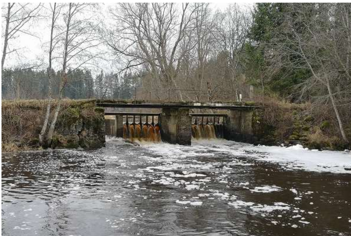
Foto 3. Vaade Sanna Mäeveski paisule alavee poolt. Liigveelaskme paremas servas (fotol vasakul) asub kalapääsu väljavool (R. Järvekül, 10.12.2019).
