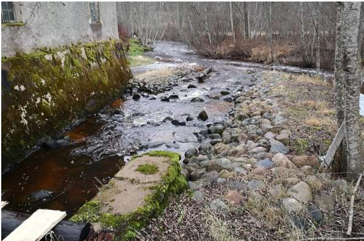
Foto 11. Vaade paisult allavoolu kalapääsule. Esiagselt rajati kalapääs kiviläbivoolude kaskaadina. Praeguseks on kivivallid enamasti juba hajusaks kärestikuks lagunened (R. Järvekülg, 10.12.2019).
