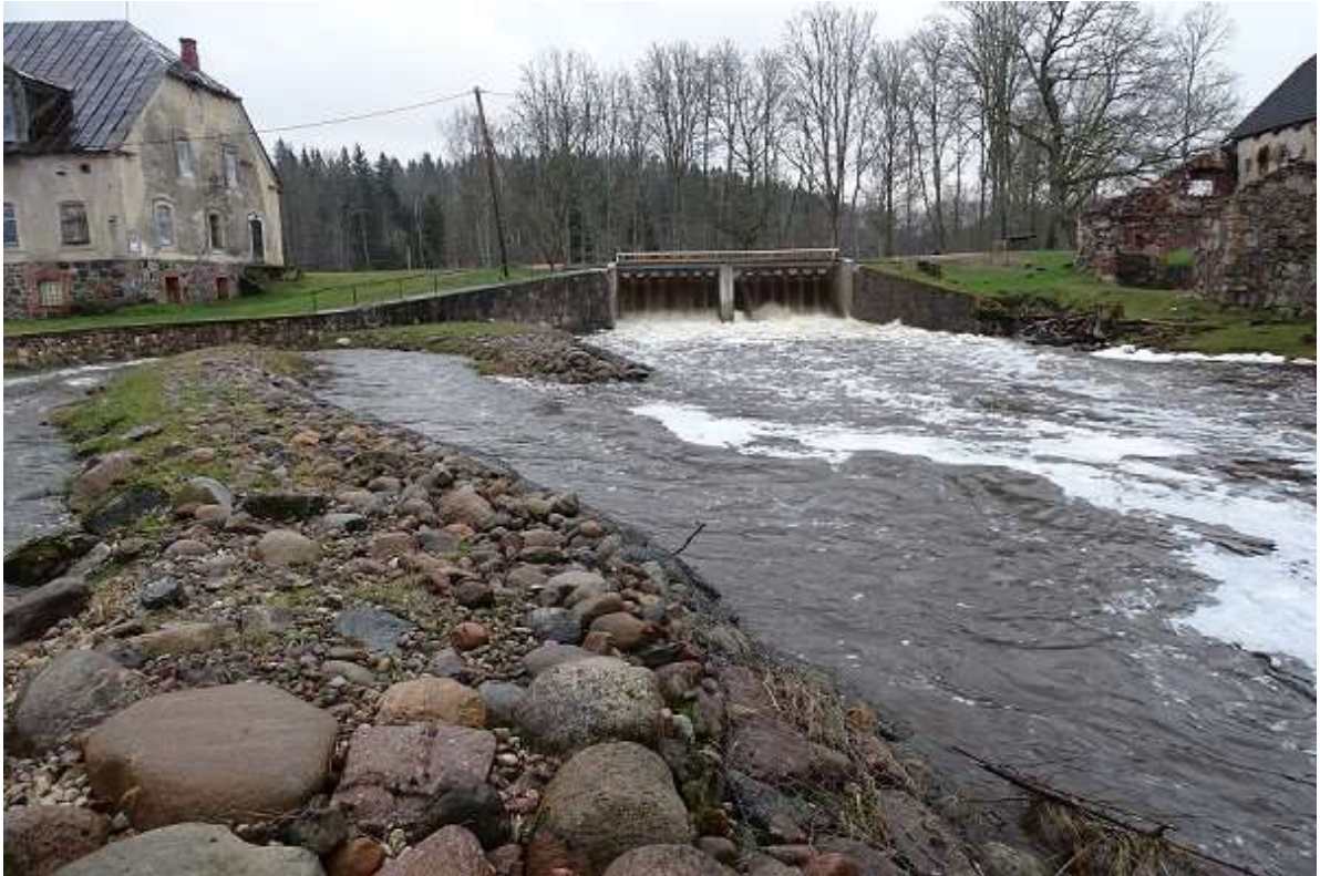
Foto 4. Vastse-Roosa pais alavee poolt vaadates. Kalapääsu väljavool asub paarkümmend meetrit liigveelaskmest allavoolu (R. Järvekül, 10.12.2019).
