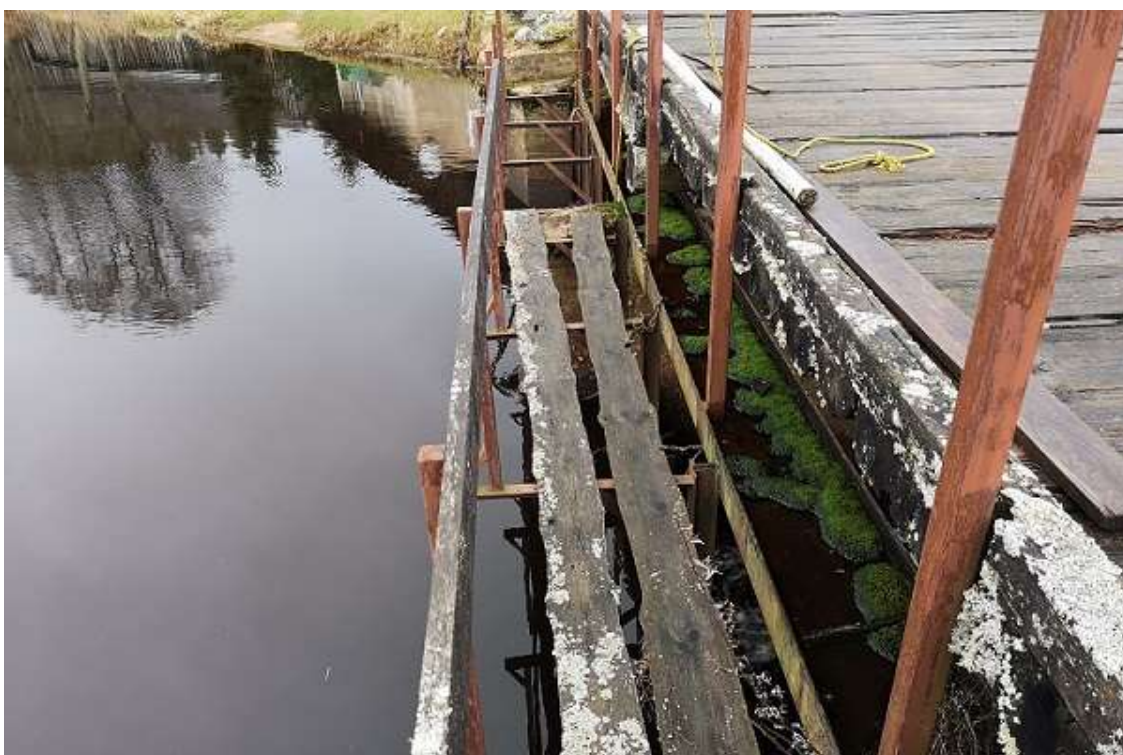
Foto 19. Liigveelaskmelt varjade eemaldamine on kaskadöörlik ettevõtmine, eriti talvel, kui lauad on jäised või lumised ja varjad on kõvasti kinni kiilunud. See on muide tavaline ka paljude Eesti paisude puhul – kui vaja kiiresti varju avada, siis pole seda sageli teha võimalik (R. Järvekülg, 08.12.2019).
