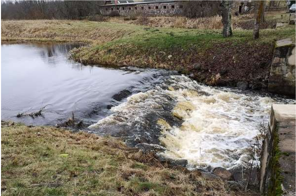
Foto 1. Jõe paremal harul asuv liigveelask, paisutuskõrgus vaatluspäeval oli 0,7 m (R. Järvekülg, 10.12.2019).
