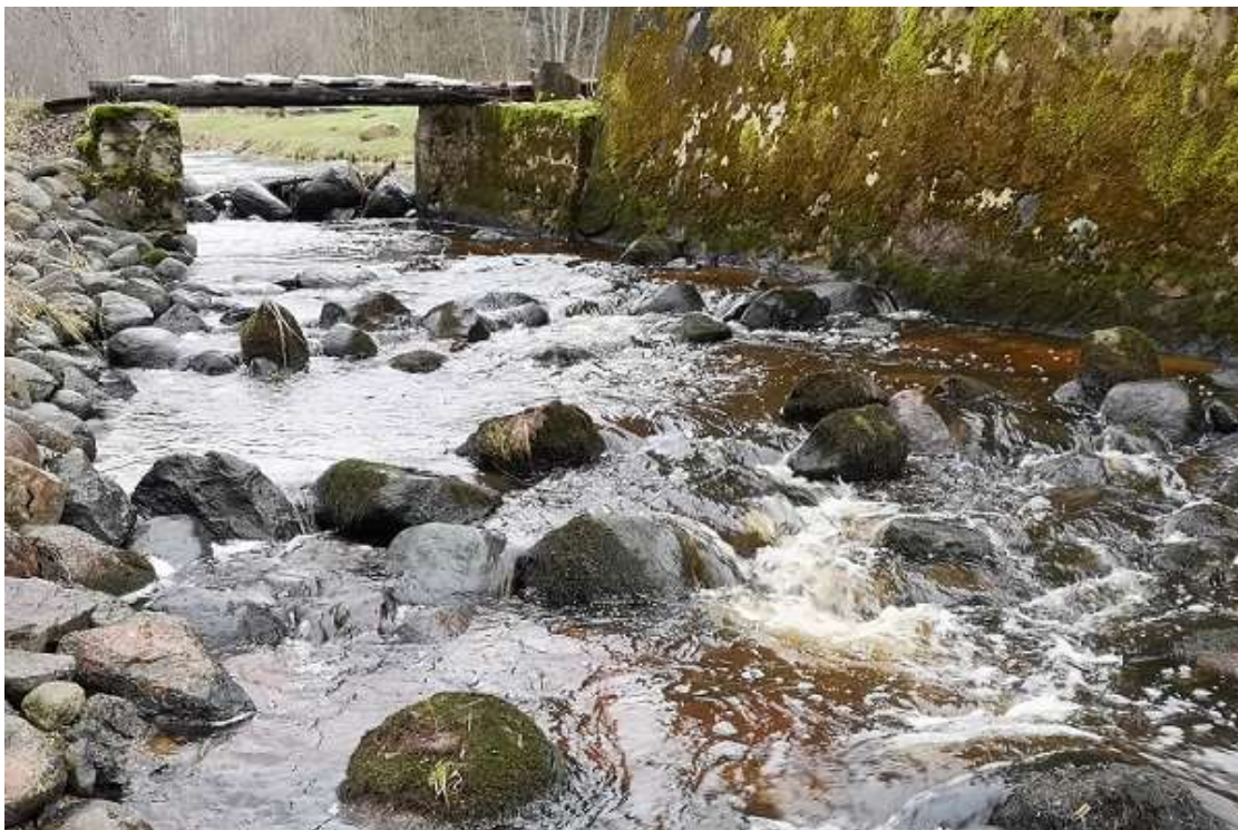
Foto 13. Kalapääsu ülemine osa. Esialgsed kiviastmed on lagunened kärestikuks. Kalapääsu sissevoolule on tekitatud kividest kuhjatis, mis tõkestab tõusval rändel olevate kalade rändetee. Kalapääs pole praegu kaladele läbitav (R. Järvekül, 10.12.2019).
