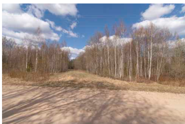
238. att. Trases krustojums ar vietējās nozīmes ceļu pie Ozolu mājām. Skats Mōisakūla virzienā AB5_R-M_118 (57 58.7301; 25 15.0904)
