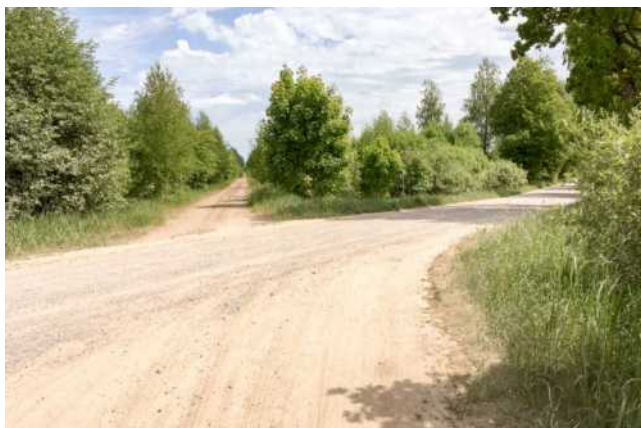
499. att. Dzelzceļa trase pie krustojuma ar autoceļu V420. Skats Gulbenes virzienā. LIMF_IMG_7171 (57 10.7695; 26 51.971)
