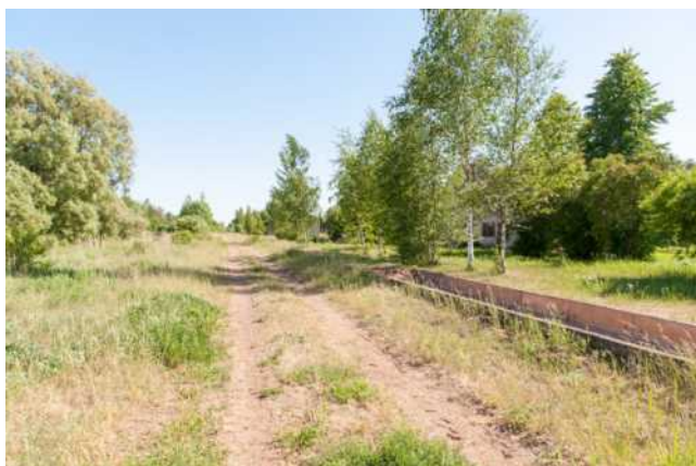
575. att. Vecumu stacijas teritorija. Perona paliekas un dzelzceļa ēkas. Skats Krievijas robežas virzienā. LIMF_AB4_3124 (57 12.8824; 27 46.3686)
