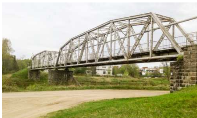
464. att. Šaursliežu dzelzceļa tilts pār Gauju Valmierā ("Dzelzītis") JS_114312 (57.528041, 25.409186)
