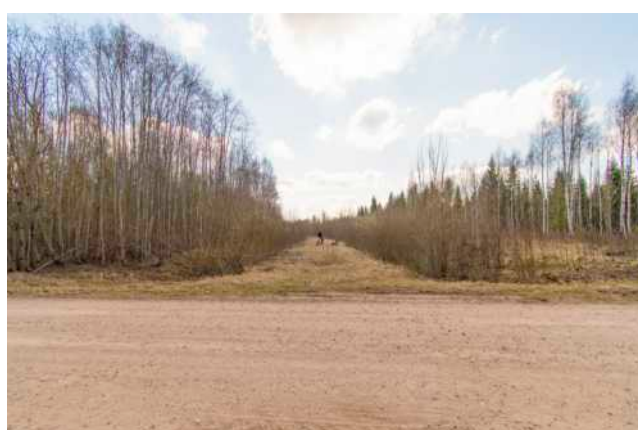
205. att. Dzelzceļa trase posmā no Rūjienas stacijas pie krustojuma ar V201 autoceļu. Skats Rūjienas virzienā. AB5_R-M_61 (57 56.1413; 25 16.9990)
