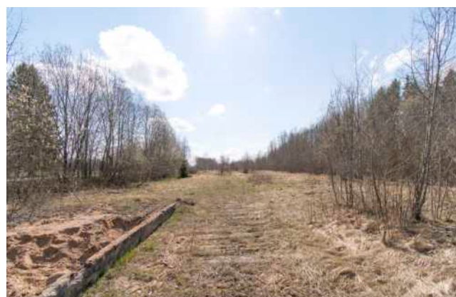
195. att. Rūjienas dzelzceļa stacijas teritorija un pasažieru platformas paliekas. Skats Rūjienas virzienā. AB5_R-M_37 (57 55.5740; 25 17.6012)
