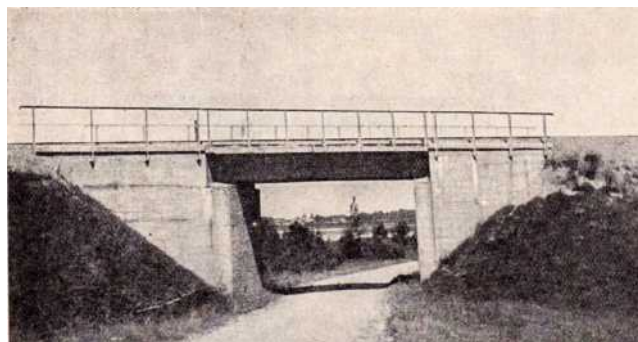
97. att. Rīgas-Rūjienas dzelzceļa līnijas būvniecība. Jaunbūvētais dzelzsbetona viadukts pār Rīgas-Limbažu šoseju pie Limbažiem. Latvijas dzelzceļi . 1918-1938. Rīga: Valsts dzelzceļu izdevniecība; 1938. 434. lpp.
