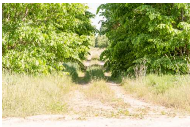
578. att. Skats uz dzelzceļa trasi no krustojuma ar vietējo ceļu Krievijas robežas virzienā aptuveni 0,8 km no Vecumu stacijas. LIMF_AB4_3132 (57 12.4663; 27 46.705)
