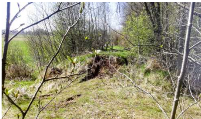
446. att. Norakts dzelzceļa uzbērums Blomes pagastā netālu no "Kubliņiem" JS_152012 (57.474705, 25.781539)
