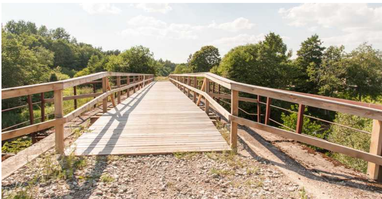
335. att. Rekonstruētais velobraucēju un gājēju tilts pār Reiu upi. Skats Pērnavas virzienā LIMF_AB4_3720 (58 19.8882; 24 36.7877)
