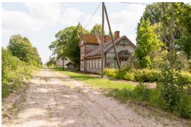
312. att. Surju stacijas pasažieru ēka un perons Skats Mōisakūla virzienā LIMF_AB4_3670 (58 15.1043; 24 44.6049)
