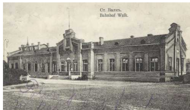
349. att. Dzelzceļa stacija Walk I (Valga), kas būvēta Rīgas-Pleskavas platsliežu dzelzceļam. 1916. Ruud van Wijnen kolekcija
