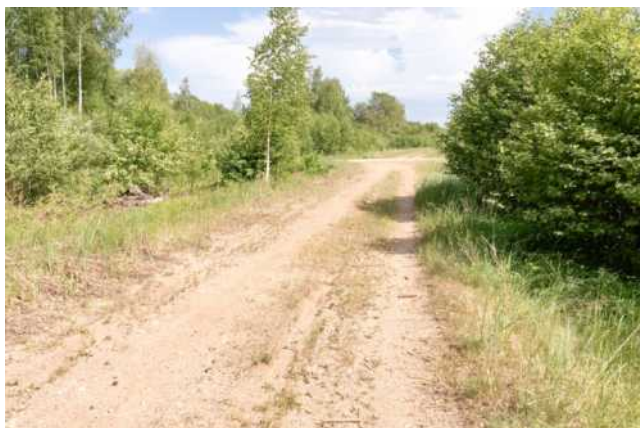
525. att. Dzelzceļa trases krustojums ar vietējo ceļu. Skats Vecumu virzienā. LIMF_IMG_7267 (57 10.6545; 27 05.8838)
