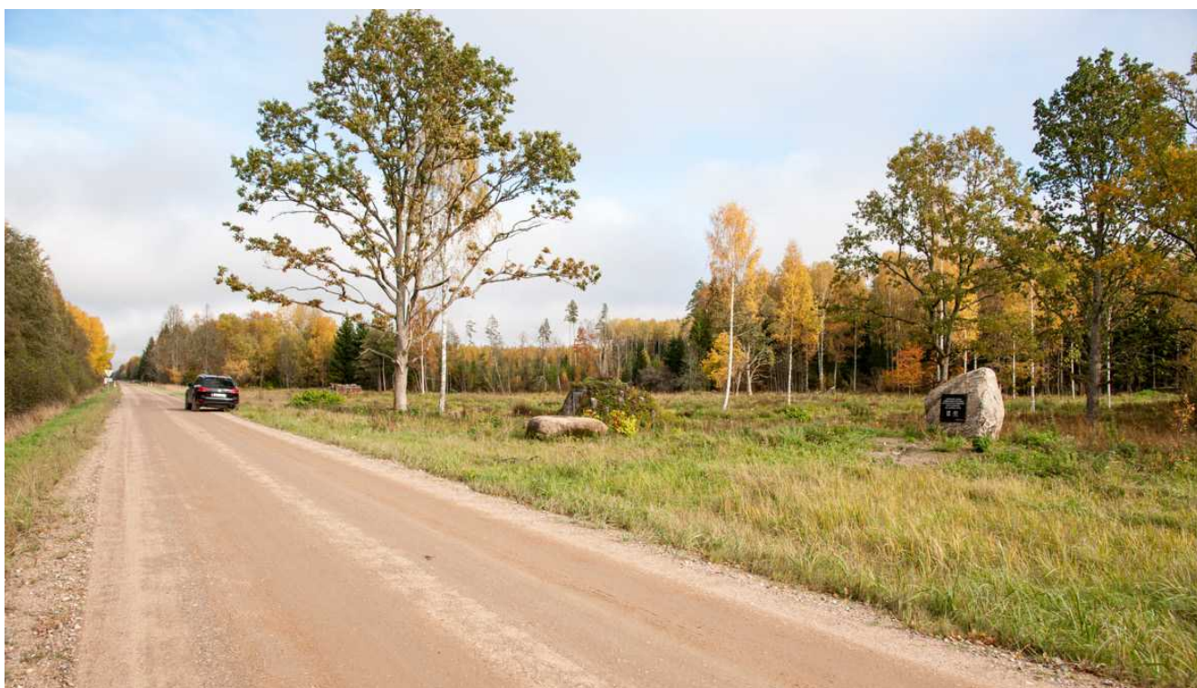
85. att. Dzelzceļa trase pie Laiksaare stacijas vietas. Skats Riiselja virzienā. LIMF_AB4_4860 (58 05.3809; 24 37.914)
