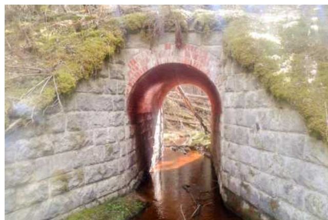
32. att. Kailā sila dzelzceļa caurteka pār ... upi JS_161227
