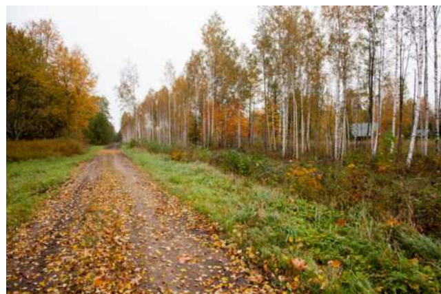
58. att. Dzelzceļa trase netālu no krustojuma ar vietējo ceļu pie Treimani kanāla. Skats Riiselja virzienā, labajā pusē Kiviloo mājas LIMF_AB4_4779 (57 54.1858; 24 26.2109)
