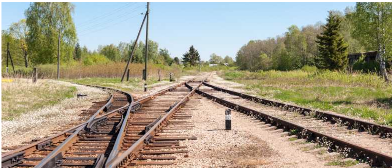
483. att. Dzelzceļa sliežu ceļu sazarojums pirms Gulbenes-Vecumu līnijas strupceļa (pa kreisi šaursliežu dzelzceļš). Skats Vecumu virzienā. LIMF_AB4_2762
