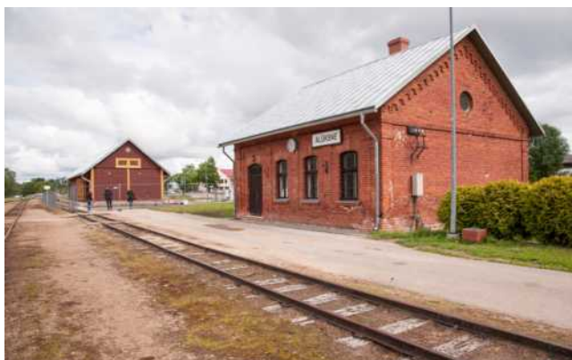
419. att. Alūksnes stacijas sliežu ceļi, pasažieru ēka un bagāžas šķūnis. Skats Apes virzienā. LIMF_AB4_3312
