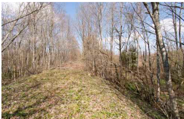
206. att. Dzelzceļa trase pie tilta pār novadgrāvi. Skats Mōisakūla virzienā. AB5_R-M_64 (57 56.3665; 25 16.8487)
