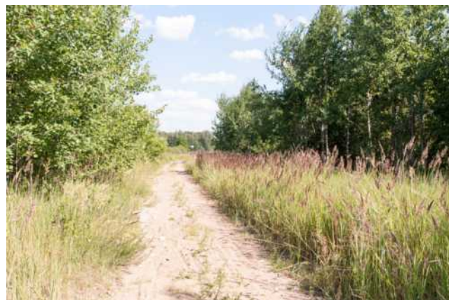
334. att. Dzelzceļa trase starp Reiu tiltu un vietējo autoceļu Skats Mōisakūla virzienā. LIMF_AB4_3715 (58 19.8893; 24 37.0411)
