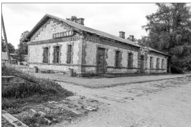
381.-382. att. Apes dzelzceļa stacijas pasažieru un bagāžas noliktavas ēka. Skats uz ēkām perona pusē. Ap 1990. LIMF_29580002 un 29580007
