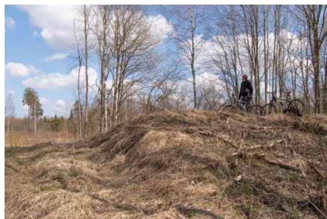
230. att. Dzelzceļa uzbēruma pārrakums. Pa labi trase Rūjienas virzienā. AB5_R-M_106 (57 58.6646; 25 15.1101)
