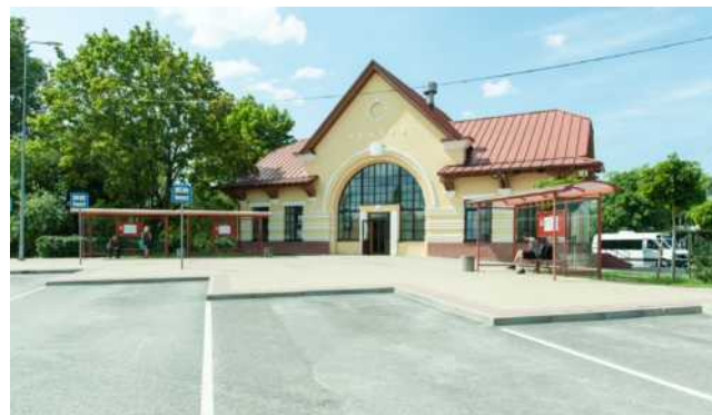
103. att. Rīgas-Rūjienas dzelzceļa Limbažu stacija. 2018. Foto: A. Biedriņš 16.07.2018. LIMF_AB43561
