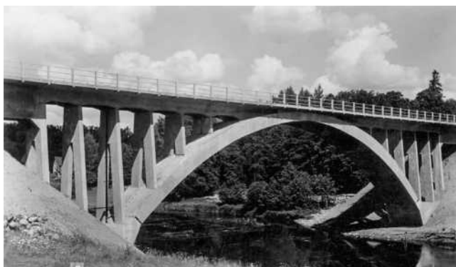
98. att. Rīgas-Rūjienas dzelzceļa betona tilts pār Salacu. 1930. gadu beigās. LDzM_2574
