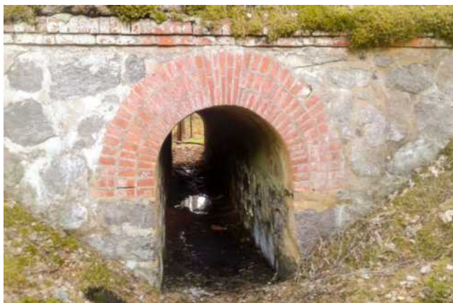
31. att. Kailā sila dzelzceļa caurteka pār JS_154949
