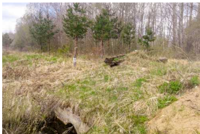
90. att. Dzelzceļa caurteka Mazsalacā pie Liepu ielas. JS_115708 (57.868063, 25.054218)
