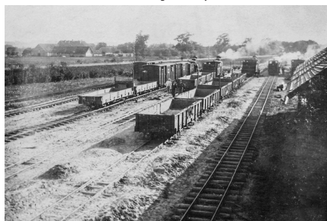
354. att. Vidzemes pievedceļu sabiedrības sliežu ceļi un ritošais inventārs Stukmaņu (Pļaviņu) platsliežu dzelzceļa stacijā. 20. gs. sākums. T. Altberga kolekcija
