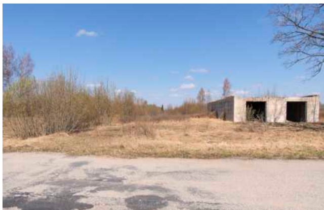
190. att. Vieta, kur dzelzceļa trase šķērso V174 autoceļu. Skats Mōisakūla virzienā. AB5_R-M_30 (57 55.2520; 25 17.9473)
