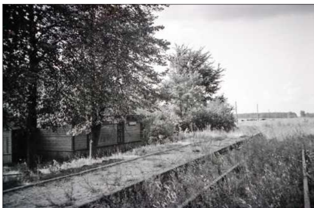
473. att. Purvmalas dzelzceļa stacijas pasažieru ēka. Foto: T. Altbergs 08.1997.
