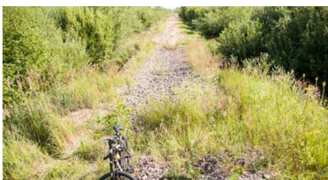
119. att. Dzelzceļa trase, skats no strupceļa Limbažu virzienā. LIMF_AB43469 (57 20.4251; 24 28.5914)
