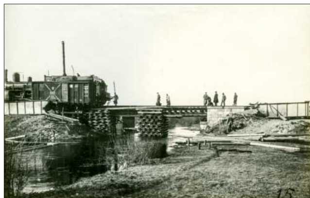
476. att. Dzelzceļa tilta būvniecība pār Bolupi. M. Sproģes kolekcija
