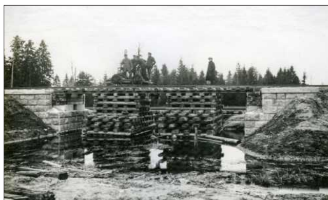
477. att. Dzelzceļa tilta būvniecība pār 118. km pār Sitas upi. M. Sproģes kolekcija
