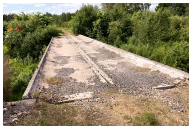
528. att. Dzelzceļa tilts pār Sitas upi. Skats Gulbenes virzienā. LIMF_IMG_7277 (57 10.5715; 27 06.1365)
