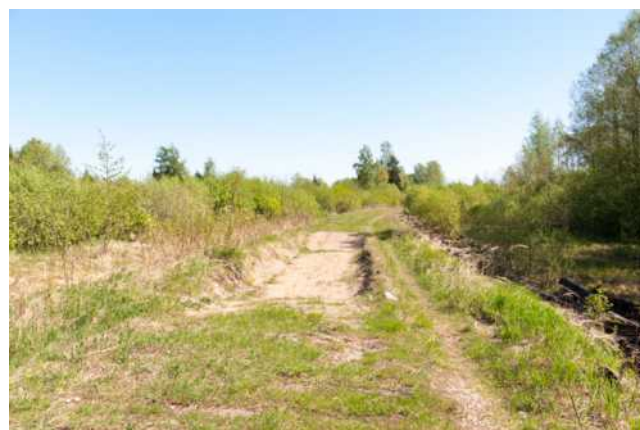
485. att. Dzelzceļa trase aiz dzelzceļa strupceļa. Skats no dzelzceļa strupceļa Vecumu virzienā. LIMF_AB4_2766
