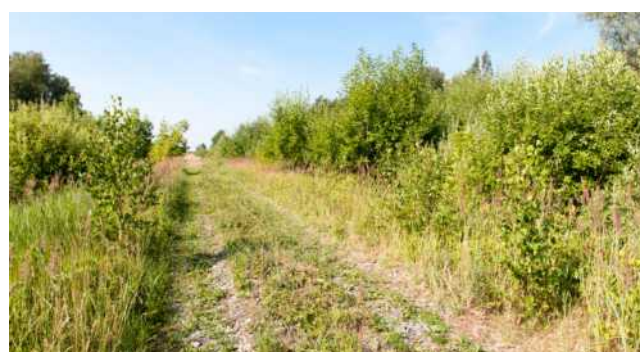
120. att. Dzelzceļa trases iepretī Kangarkalnu mājām vietā, kur Rail Baltica trase krusto uzbērumu, skats Skultes virzienā. LIMF_AB43475 (57 20.5397; 24 28.7507)
