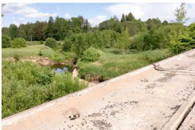
527. att. Dzelzceļa tilts pār Sitas upi. LIMF_IMG_7274 (57 10.5775; 27 06.1153)
