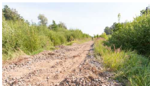
118. att. Trase posms ar mīkstu grants bērumu, skats Limbažu virzienā. LIMF_AB43473 (57 20.4955; 24 28.6899)
