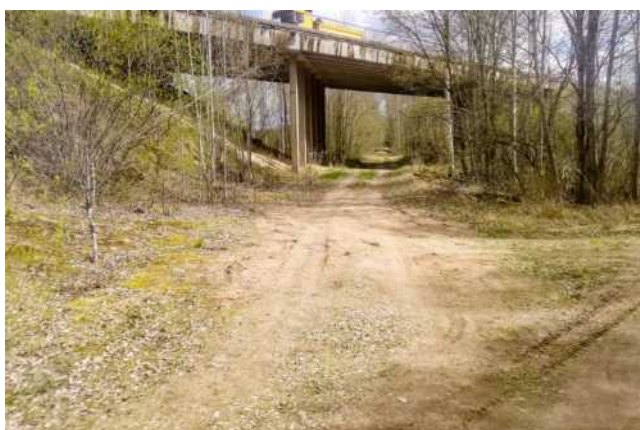
172. att. Dzelzceļa trase zem P21 šosejas viadukta virzienā uz agrāko Rūjienas stacijas vietu. JS_124459 (57.912401, 25.287557)
