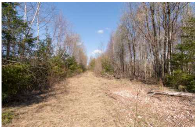
200. att. Dzelzceļa trase posmā no Rūjienas stacijas līdz krustojumam ar V201 autoceļu. Skats Mōisakūla virzienā. AB5_R-M_49 (57 56.8988; 25 17.4210)
