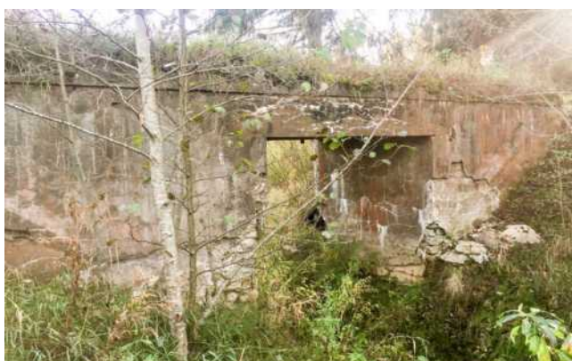
379. att. Dzelzceļa tilts netālu no 67. autoceļa. JS_00133 (57.711677, 26.219035)
