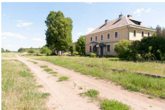
561. att. Žiguru stacijas pasažieru ēka un perona paliekas Skats Vecumu virzienā. LIMF_AB4_3068 (57 15.7838; 27 39.9246)
