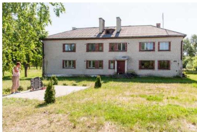
576. att. Vecumu dzelzceļa stacijas pasažieru ēka (tag. dzīvojamā ēka) un piemiņas zīme deportētajiem. LIMF_AB4_3125 (57 09.873; 27 12.4155)
