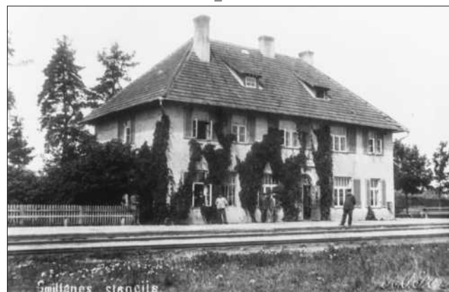
425. att. Smiltenes dzelzceļa stacijas pasažieru ēka. Atklātne. 1930. gadi. LIMF_AB34912
