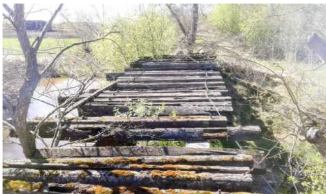
448. att. Dzelzceļa tilts pār Nigru. Skats Valmieras virzienā JS_153645 (57.475675, 25.773271)
