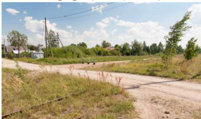
291. att. Mōisakūla stacijas sliežu ceļš. Skats Rūjienas virzienā LIMF_AB4_3615 (58 05.3967; 25 11.4374)
