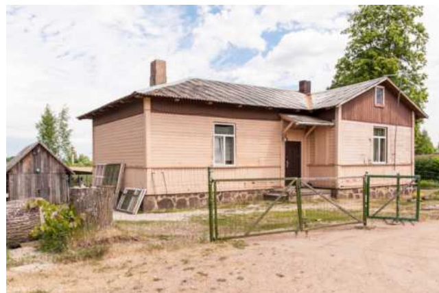
493. att. Melnupes stacijas pasažieru, ēka, tagad dzīvojamā ēka. Skats Vecumu virzienā. LIMF_AB4_2823 (57 11.1087; 26 50.985)
