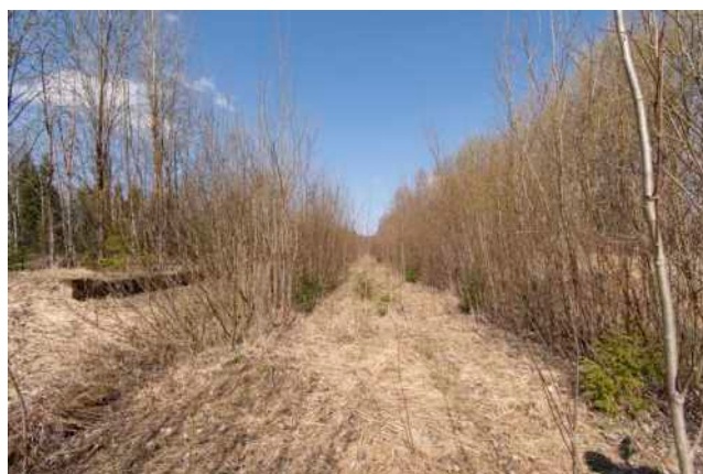
203. att. Dzelzceļa trase posmā no Rūjienas stacijas līdz krustojumam ar V201 autoceļu. Dzelzceļa ēkas pamati. Skats Mōisakūla virzienā. AB5_R-M_57 (57 56.0245; 25 17.0944)
