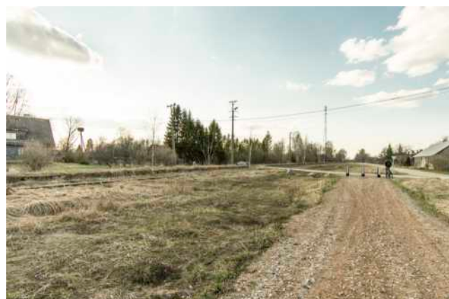
283. att. Trase Mōisakūla pilsētā pie krustojuma ar ar Viljandi ielu. Skats Mōisakūla stacijas virzienā. AB5_R-M_214 (58 05.3748; 25 11.4755)
