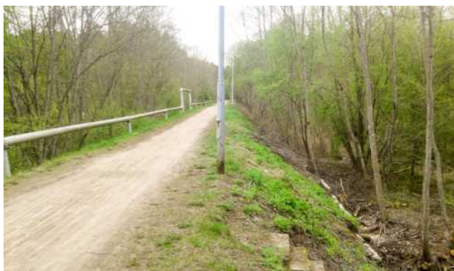
463. att. Gājēju un velosipēdistu ceļš Valmierā pie Zvejnieku ielas JS_113840 (57.527386, 25.414333)
