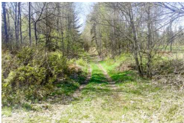
442. att. Dzelzceļa trase pie "Starīņiem" JS_145216 (57.471393, 25.808361)
