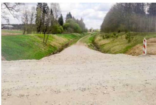
87. att. Dzelzceļa trase Mazsalacā pie Parka ielas. JS_114010 (57.862464, 25.041145)
