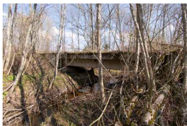
209. att. Betona tilts pār novadgrāvi. AB5_R-M_66 (57 56.3665; 25 16.8487)
