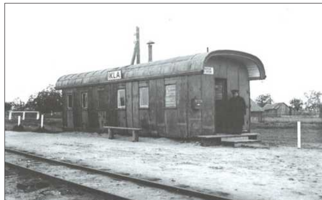
41. att. Ikla pagaidu stacijas ēka. 1927. Grām.: Helme M. Narrow-gauge Supply Railways in Estonia (1895-1975) . B.v.: M. Helme, 2010, p. 95
