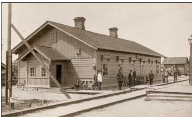
469. att. Vecumu dzelzceļa stacijas pasažieru ēka. Atklātne. 1920. gadi. M. Sproģes kolekcija
