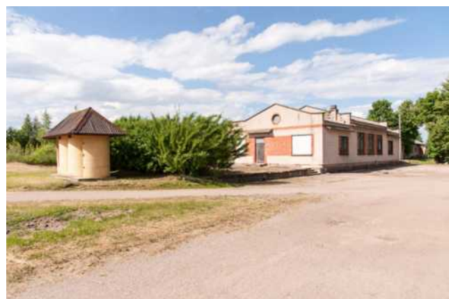
540. att. Kopskats uz Balvu dzelzceļa stacijas pasažieru ēku no stacijas laukuma puses. LIMF_IMG_3425 (57 09.8795; 27 12.382)
