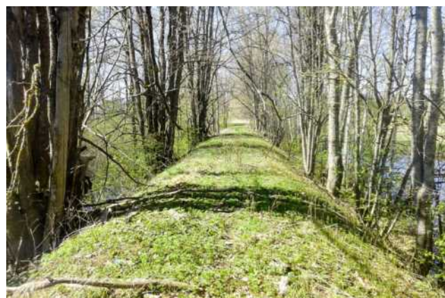
438. att. Dzelzceļa uzbērumš netālu no "Jenceriēm". JS_143352 (57.468992, 25.819667)
