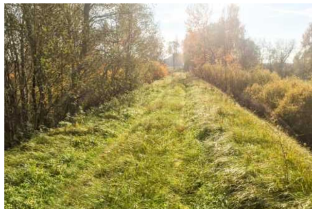
376. att. Dzelzceļa uzbērumš netālu no "Sikatari" mājām un Ujuste upes. JS_00128 (57.734375, 26.208287)
