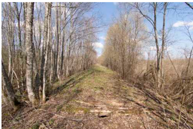
210. att. Dzelzceļa trase pie tilta pār novadgrāvi. Skats Mōisakūla virzienā. AB5_R-M_70 (57 56.3764; 25 16.8400)
