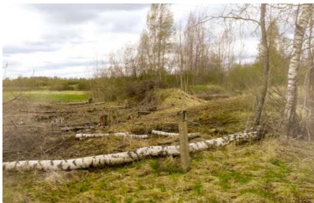
18. att. Dzelzceļa trase Ipiķu virzienā. JS_130104
