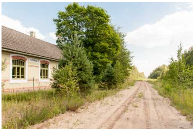
321. att. Vaskaama stacijas pasažieru ēka un perona vieta. Skats Mōisakūla virzienā LIMF_AB4_3693 (58 17.721; 24 40.231)
