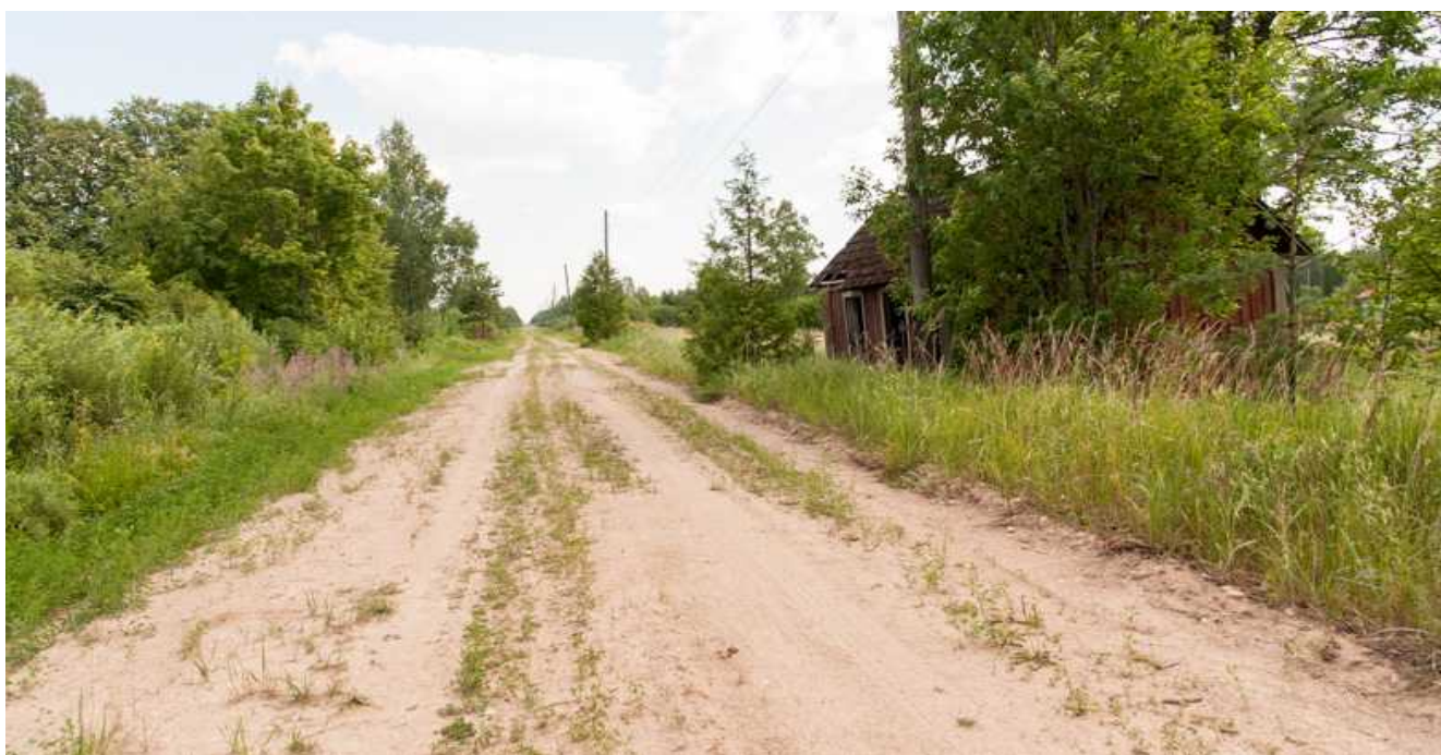
316. att. Surju stacijas saimniecības ēka. Skats Mōisakūla virzienā LIMF_AB4_3679 (58 15.0589; 24 44.6966)
