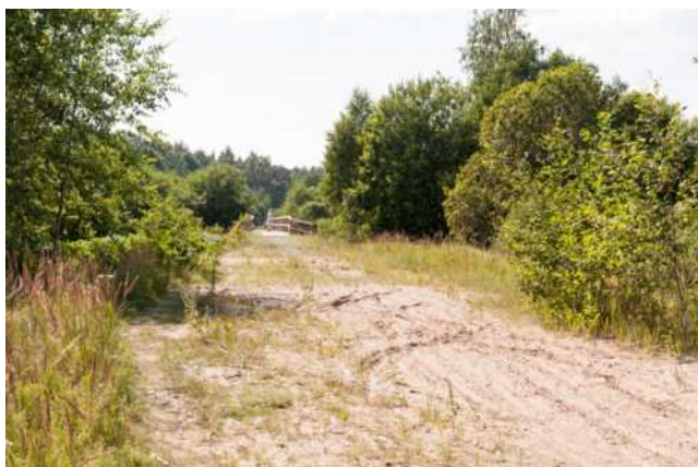
336. att. Rekonstruētais velobraucēju un gājēju tilts pār Reiu upi. Skats Pērnavas virzienā LIMF_AB4_3718 (58 19.8906; 24 36.8714)
