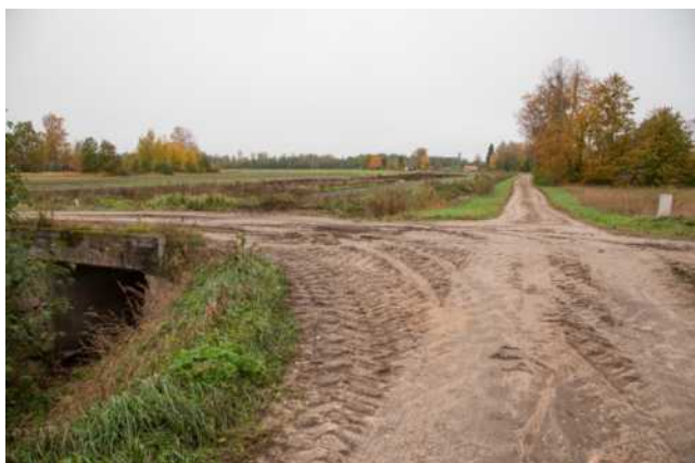
57. att. Dzelzceļa tilts pār Treimani kanālu pie Prints mājām. Skats no vietējā ceļa autoceļa E67 virzienā LIMF_AB4_4776 (57 54.1508; 24 26.1866)
