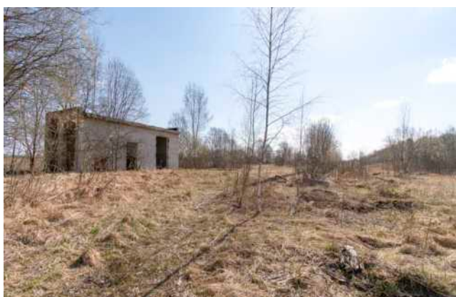
194. att. Rūjienas dzelzceļa stacijas teritorija un pasažieru platformas paliekas. Skats Rūjienas virzienā. AB5_R-M_44 (57 55.6680; 25 17.5034)
