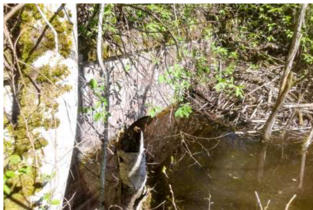
443. att. Dzelzceļa caurteka netālu no "Kalna Brīņiem" JS_150459 (57.472882, 25.796194)
