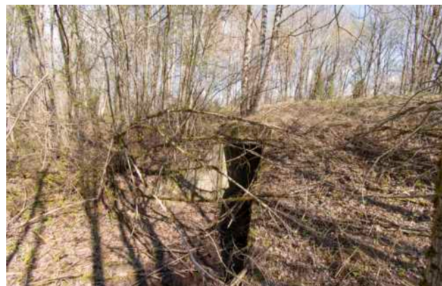
216. att. Betona caurteka pār novadgrāvi. AB5_R-M_79 (57 56.9512; 25 16.4479)
