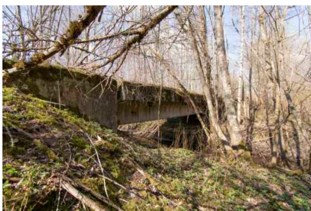
208. att. Betona tilts pār novadgrāvi. AB5_R-M_65 (57 56.3665; 25 16.8487)
