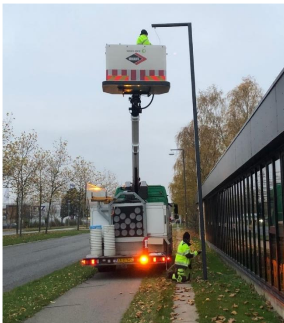
Figur 5 - Udskiftning af armatur - til nyt med radar sensor monteret i Zhaga sokkel
